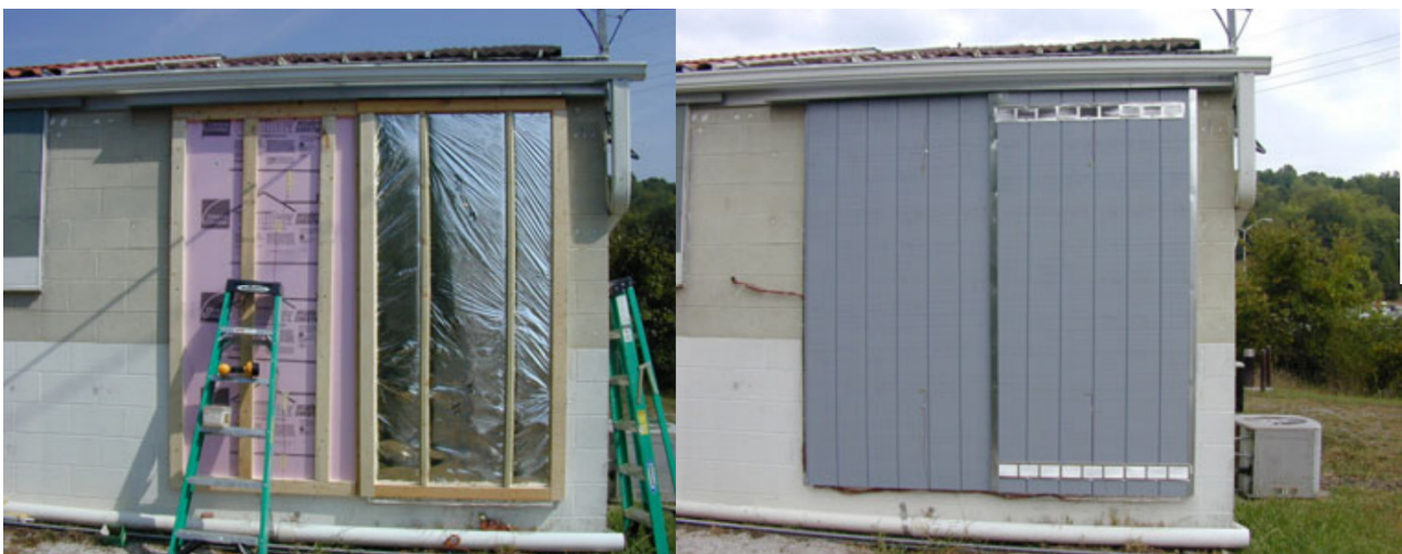
Figura 20 - Parede experimental com isolamento convencional (painel da esquerda) vs. isolamento reflexivo otimizado com PCM (painel da direita). Fonte: (KOSNY; YARBROUGH, 2008)
