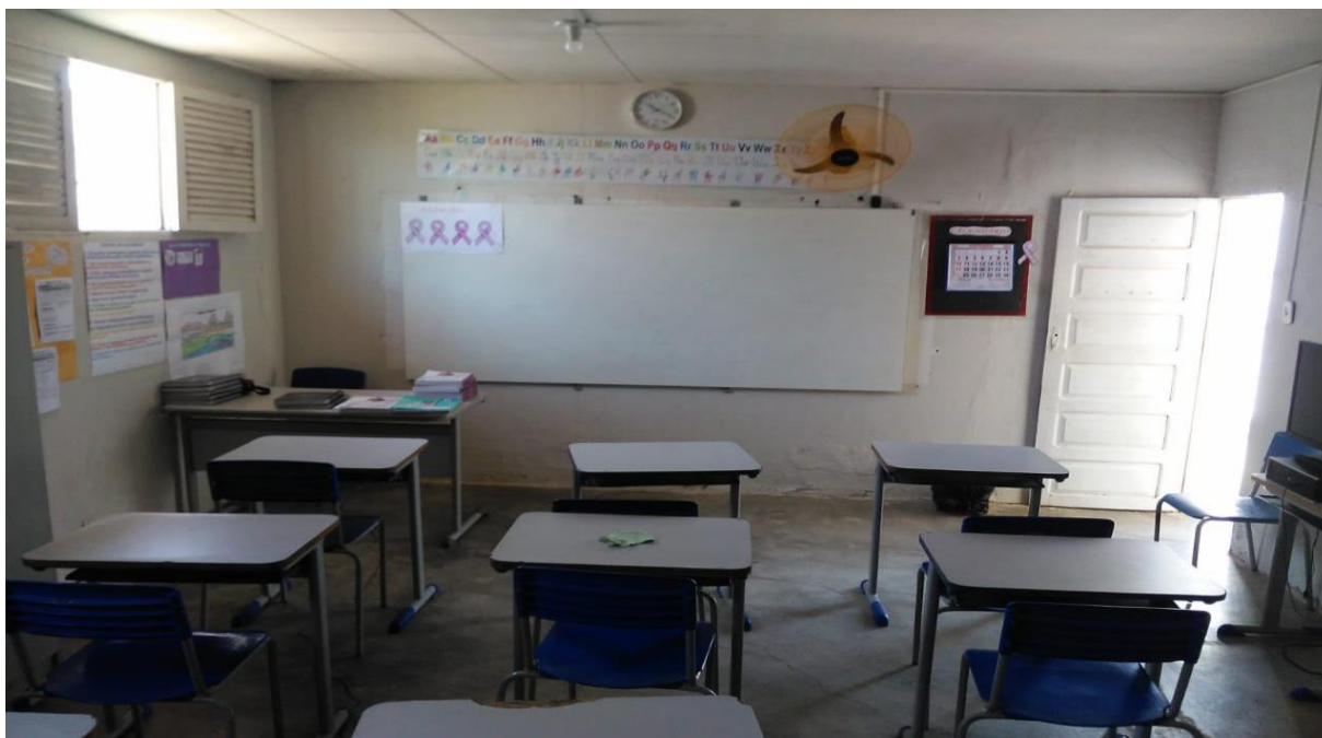
Foto 21 – Sala de aulas
