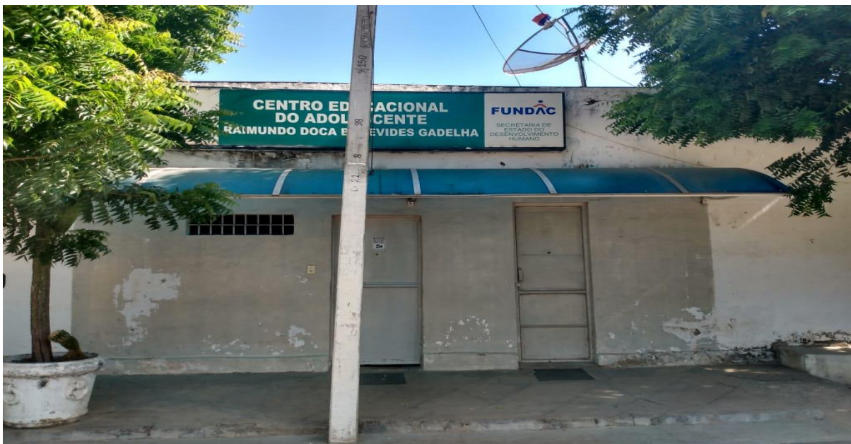
Foto 9 – Entrada da Unidade CEA/Sousa
