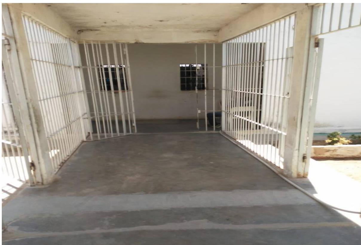
Foto 24 – Corredor de acesso aos quartos
