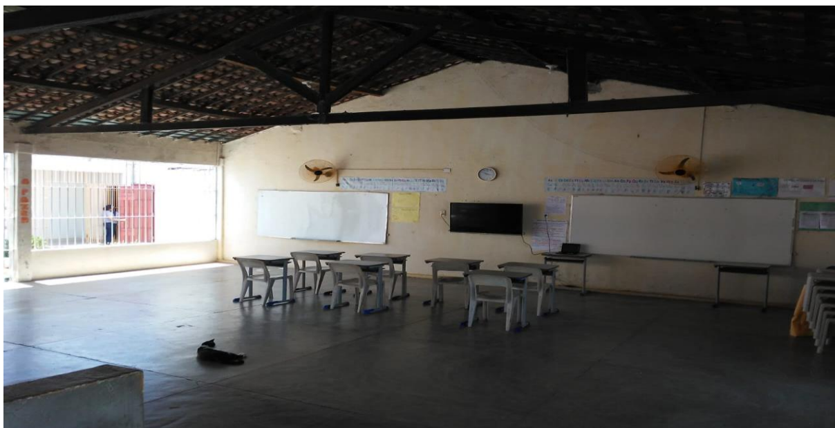
Foto 23 – Sala de aulas adaptada no Galpão (onde deveria funcionar o refeitório)
