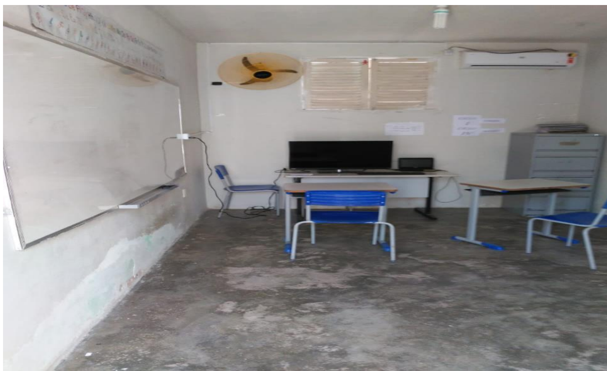
Foto 22 – Sala de Aulas
