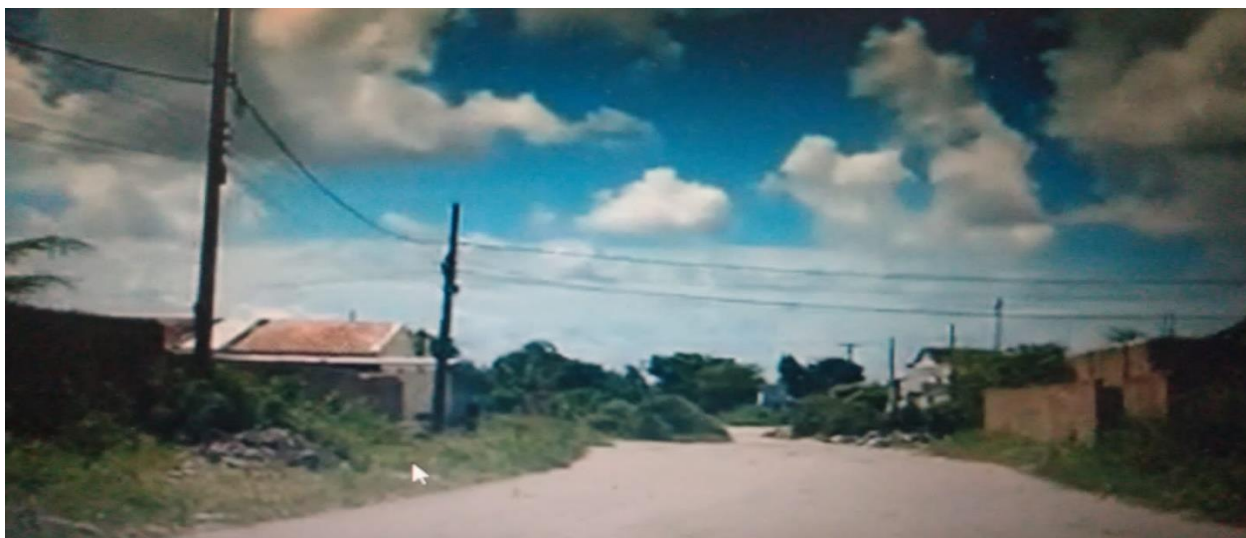
Foto 4 – Rua do bairro Vila Tibiri
