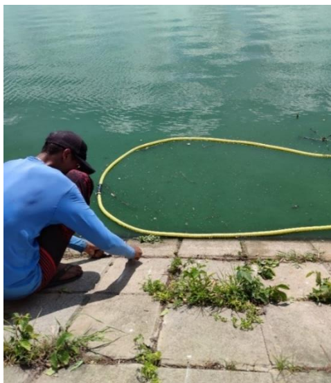
Figura 6 – Estruturas de conduítes amarradas nas margens da lagoa facultativa.
