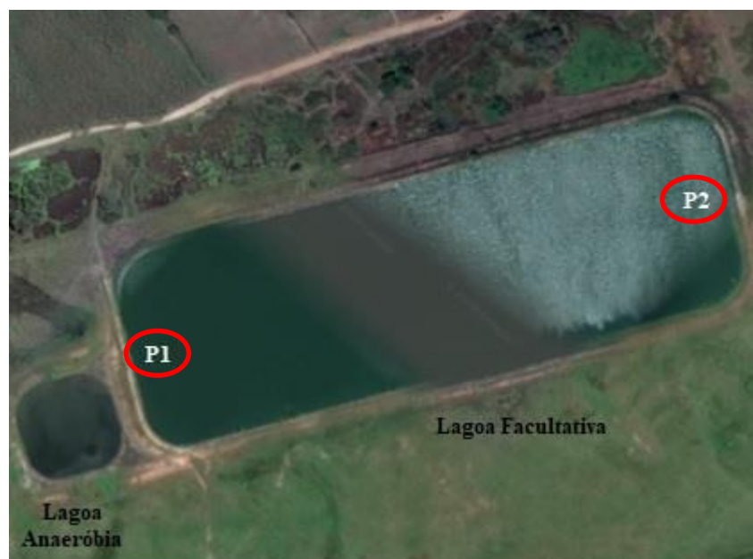
Figura 2 – Vista aérea da ETE-Mamanguape, com localização dos pontos amostrais.
