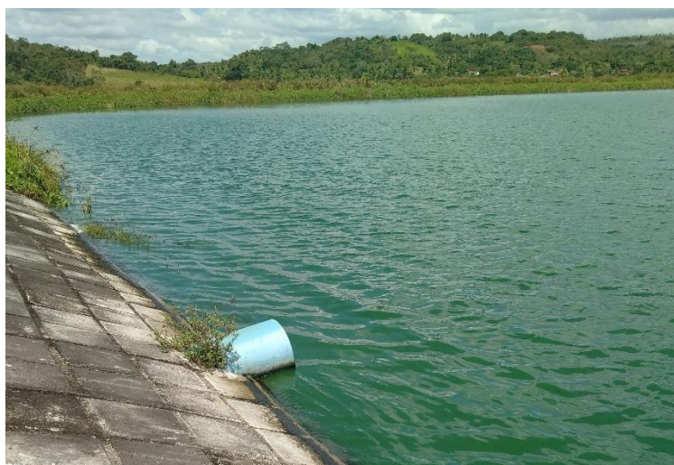
Figura 4 – Saída do Esgoto da ETE através de tubulação de 400 mm.
