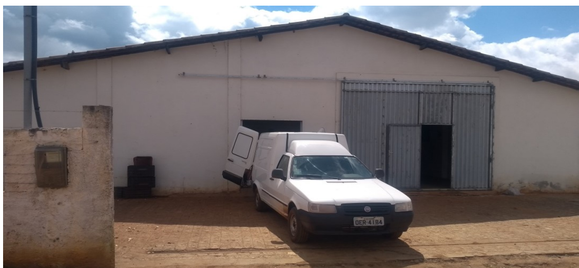
Figura 55 - Instalações conjuntas da UNITUBA com a COOPAC
