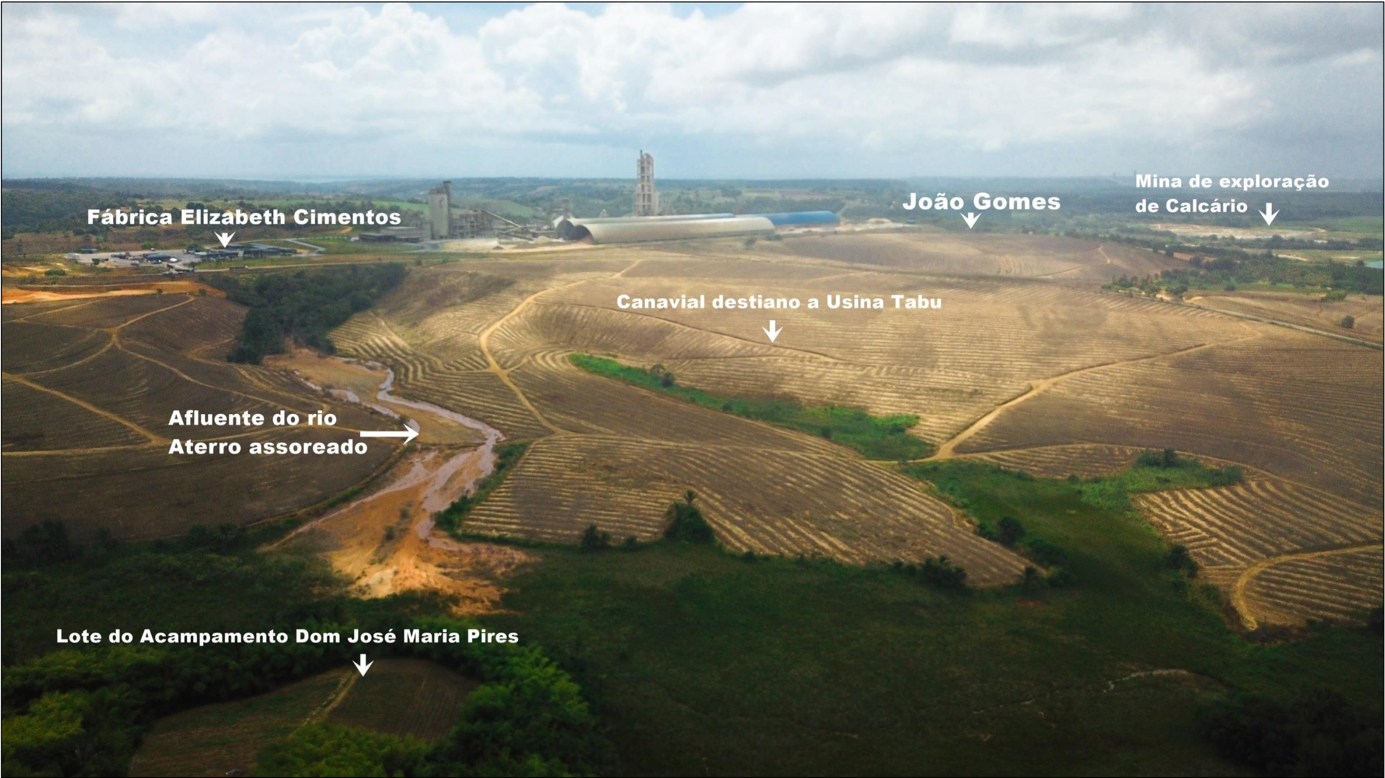
Figura 19 – Vista Panorâmica - assoreamento do afluente do rio Aterro na área circundante a indústria Elizabeth Cimentos
