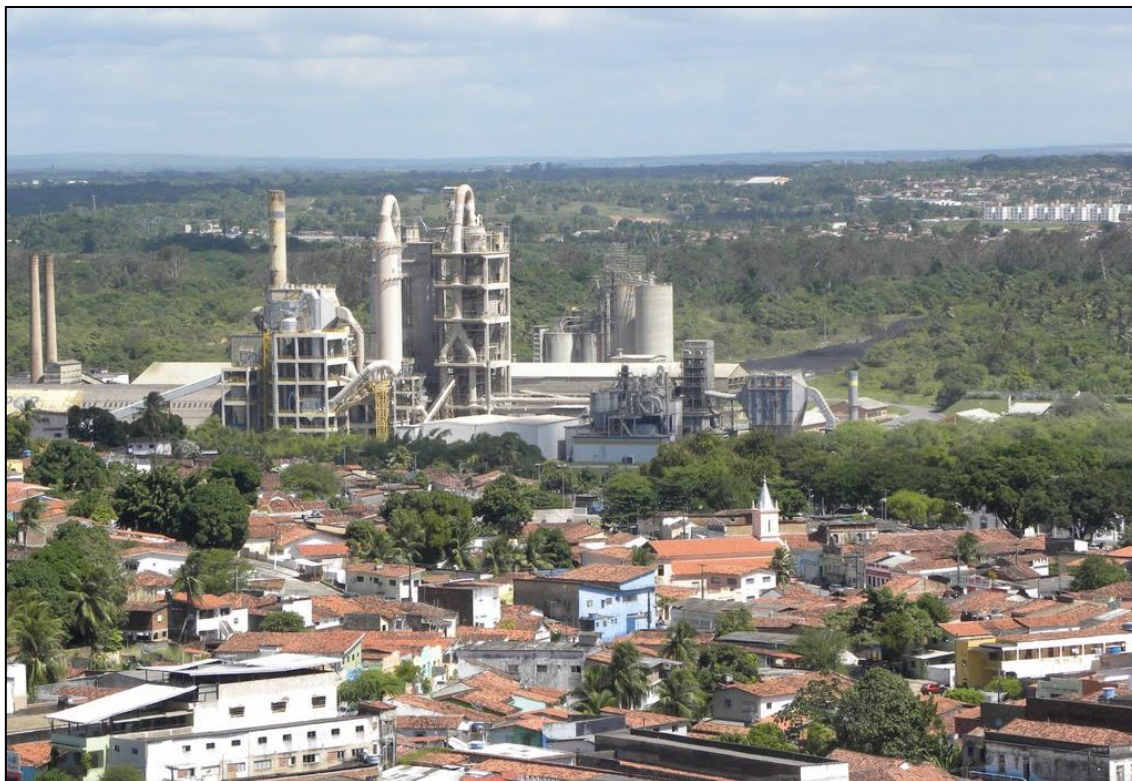
Figura 3 – Fábrica InterCement localizada no bairro da Ilha do Bispo no município de João Pessoa/PB
