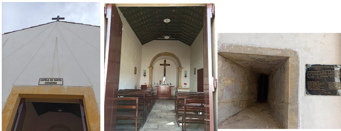
(1) Frente da Capela; (2) Nave central da capela; (3) Espessura das paredes.
