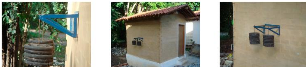
Figura 81: Execução do ensaio de peça suspensa do protótipo com blocos solo-cimento
