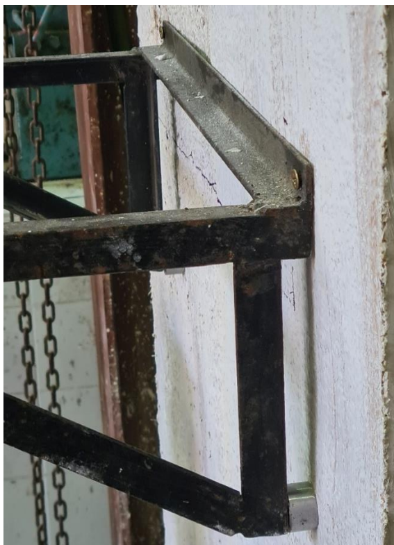
Figura 78: Detalhe da fixação do dispositivo após 24h sob carregamento total
