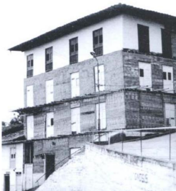
Figura 16: Edificação construída com o sistema de painéis do tipo bahareque
