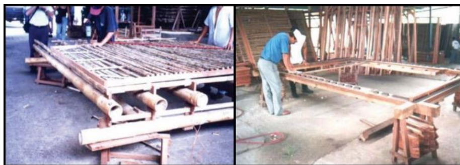
Figura 8: Gabarito e Montagem dos painéis de bambu
