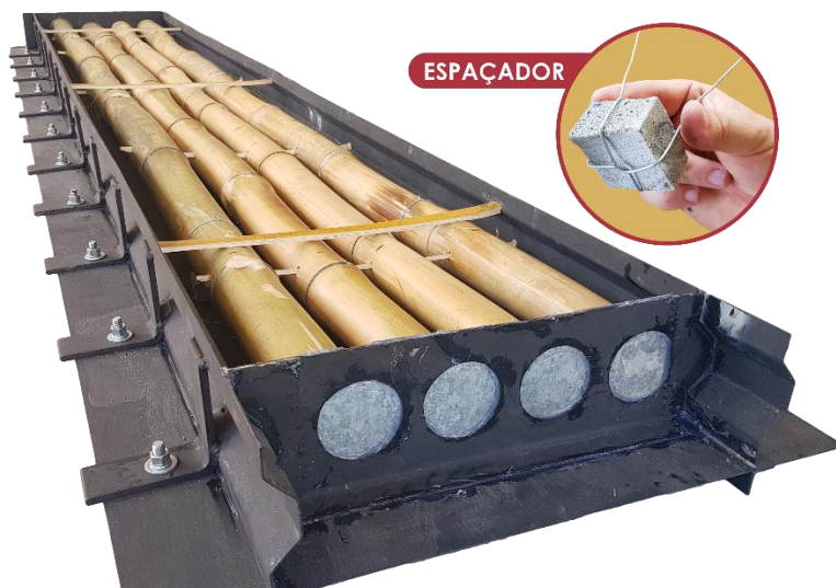
Figura 44: Forma do painel modular pronto para concretagem
