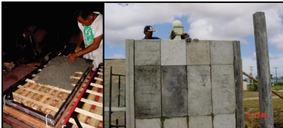
Figura 3: Painel pré-moldado em execução desenvolvido no Instituto do Bambu
