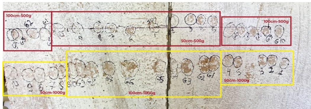
Figura 83: Marcação dos impactos de corpo duro no Módulo 2
