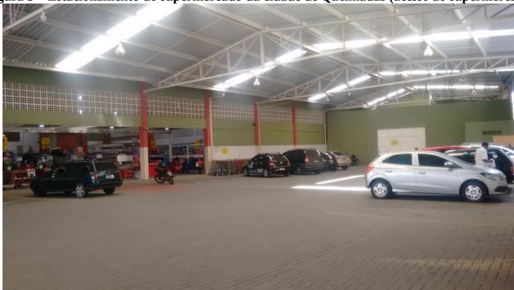
Figura 3 – Estacionamento do supermercado da cidade de Queimadas (acesso ao supermercado)
