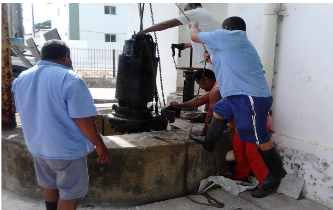
Foto 6 - Manutenção de Bomba Submersível
