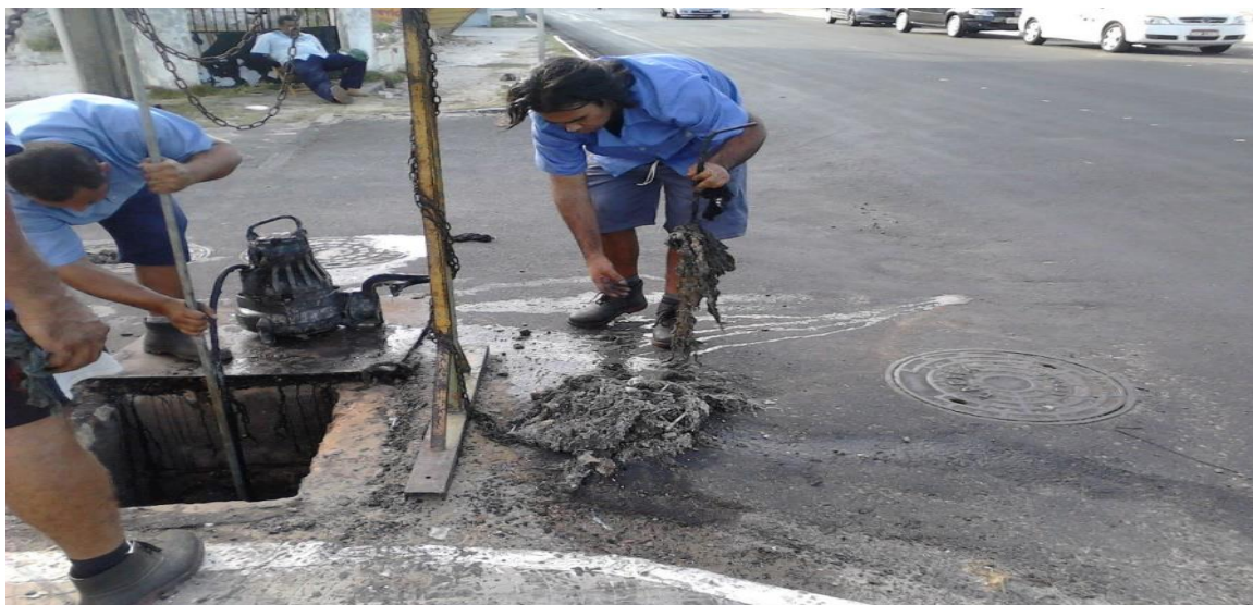
Foto – 7 Limpeza do lixo acumulado na Bomba
