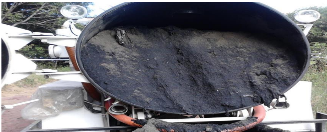
Foto 4 - Areia retirada da elevatória de esgotos
