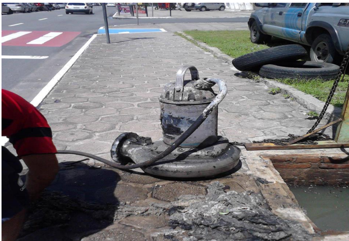
Foto 8 - Bomba pronta para recolocação
