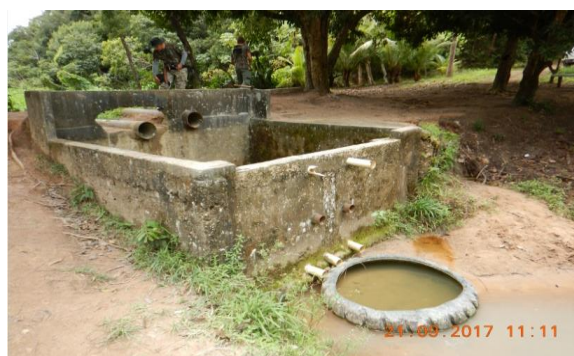
Foto 42: Estrutura do barreiro
