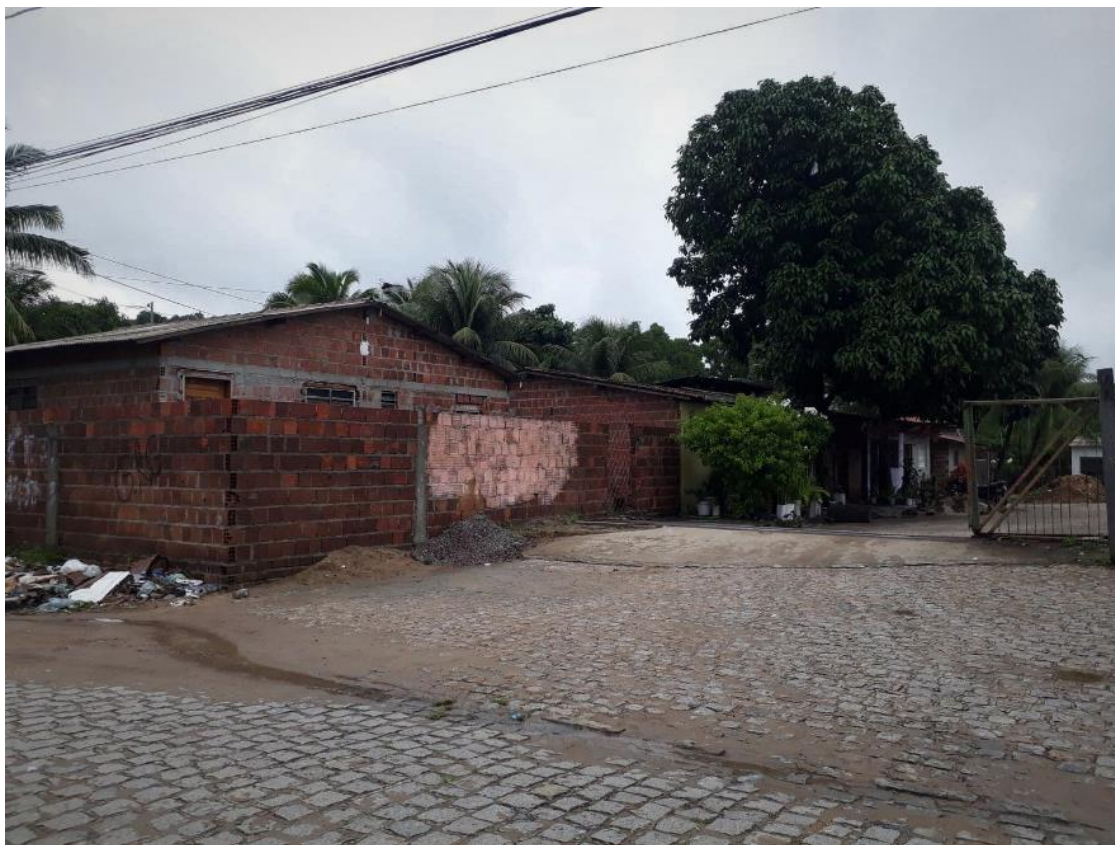
Figura 7. Casa em construção, toda murada e porta de entrada para o Curtume, ocupação feita em 2013, Porto do Capim (2017). Foto: Sarayna Martins Mendes.
