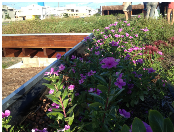
Figura 18. Telhado verde da casa ecológica 1 ano após a construção. Fonte: Autor (2014).
