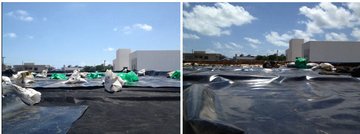
Figura 15. (a) e (b). Aplicação da manta asfáltica. Fonte: Autor (2013).
