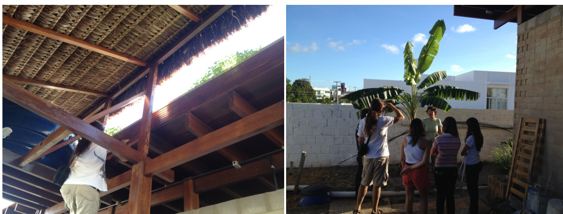
Figura 11. (a) Estrutura em madeira (b) Área externa da residência. Fonte: Autor (2014).
