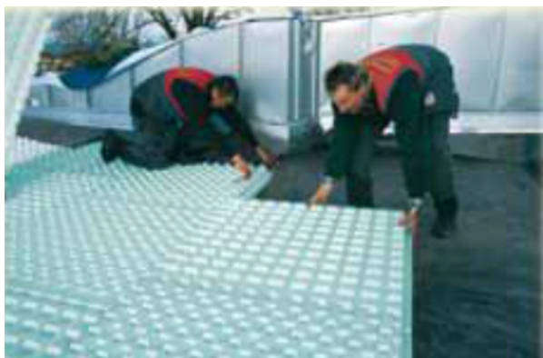
Figura 06. Aplicação da camada de drenagem.
