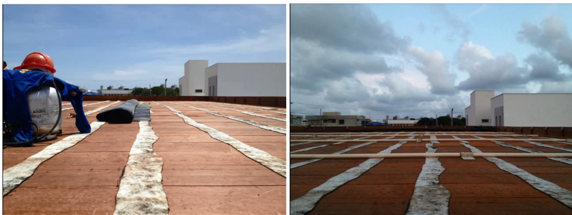
Figura 13. (a) e (b) Aplicação do Betume. Fonte: Autor (2013).
