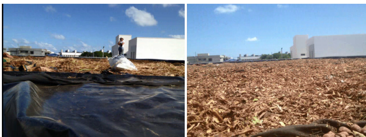
Figura 16. (a) e (b). Aplicação do substrato. Fonte: Autor (2013).
