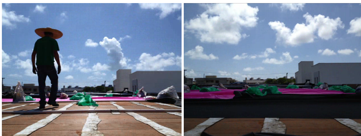
Figura 14. (a) e (b). Aplicação da Manta Geotextil. Fonte: Autor (2013).
