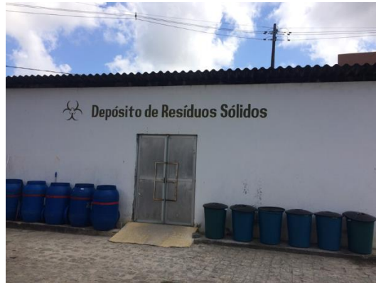
Figura 20: Armazenamento Externo de resíduos infectantes do hospital estudado.
