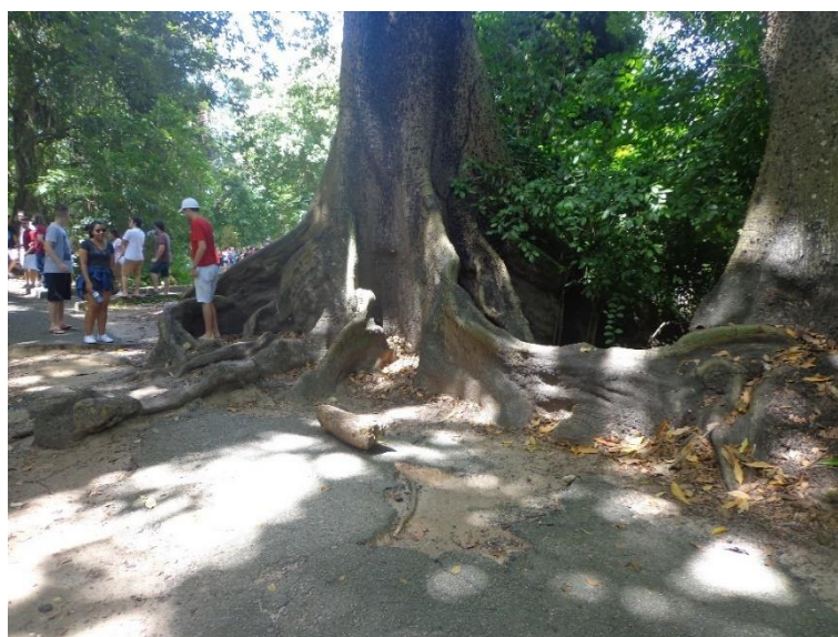
Figura 19 – Calçamento comprometido devido raízes expostas.
