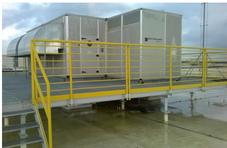
Figura 21- Unidade de Tratamento de Ar (AHU).
