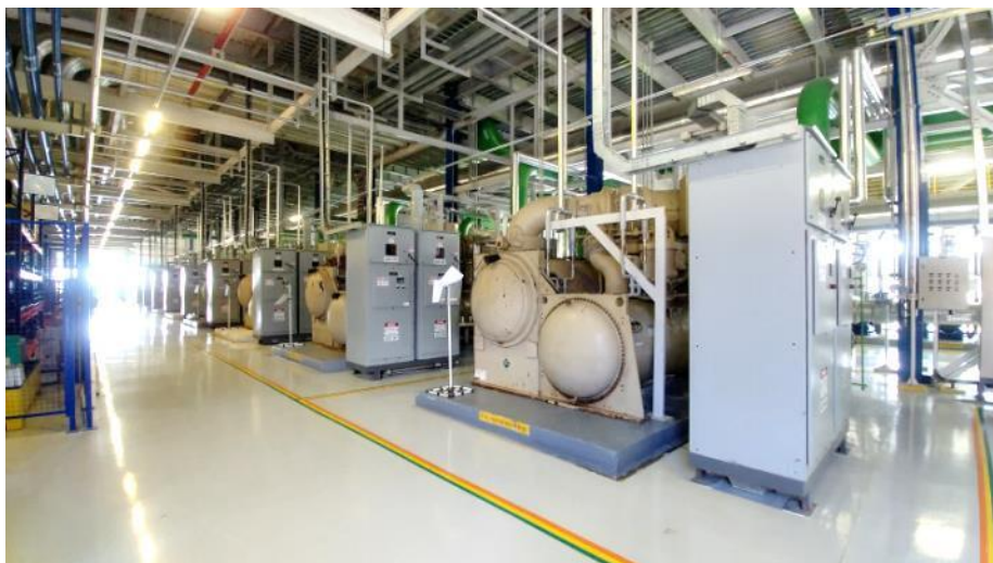
Figura 18- Chillers localizados no Energy Center.
