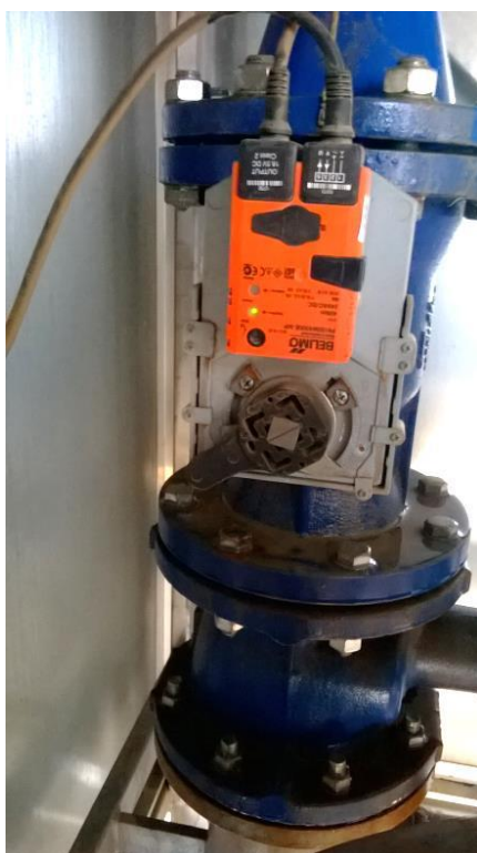
Figura 16- Válvula de controle proporcional.
