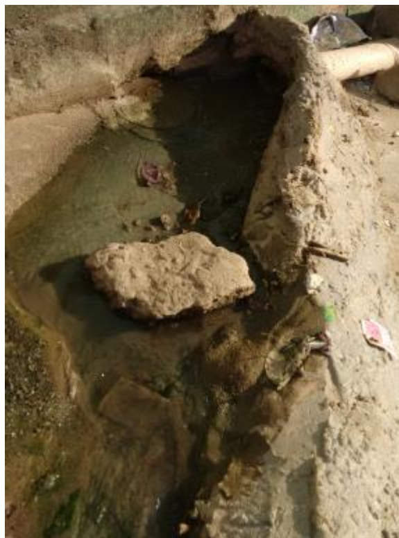
Figura 44 - Vazamento de esgoto doméstico.
