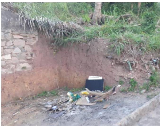
Figura 15 - Erosão no talude na parte ausente de contenção.
