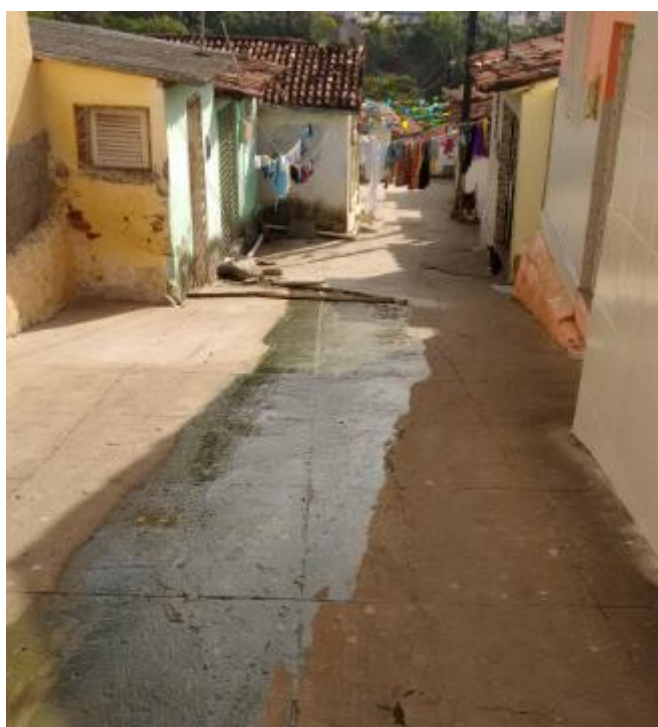
Figura 43 - Vazamento de esgoto doméstico pelo arruamento da comunidade.
