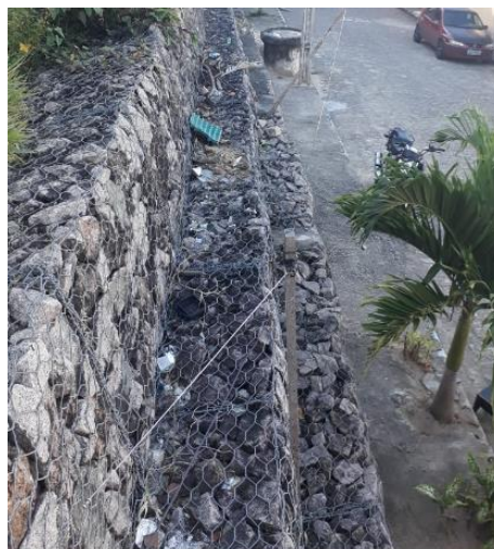
Figura 14 - Boas condições do muro de contenção.
