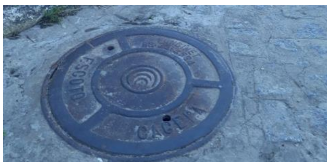
Figura 17- Coletor de esgoto.
