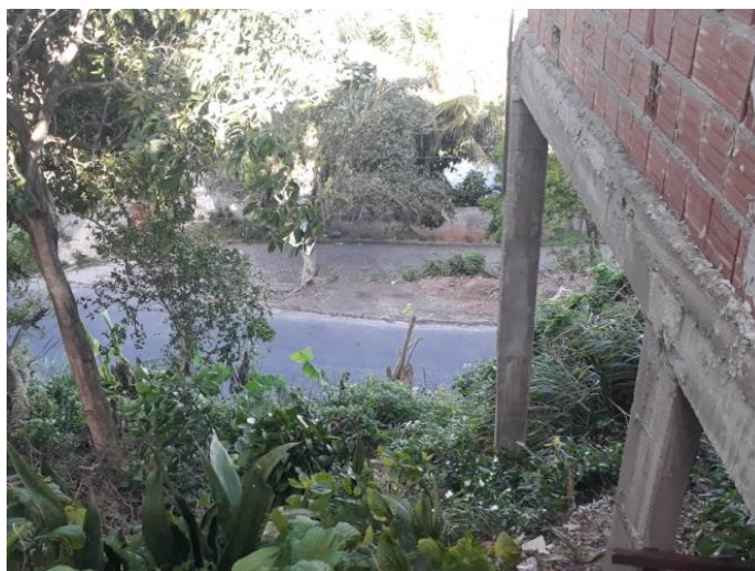
Figura 28 - Casa com as estruturas de sustentação cortando o talude: vista de cima do talude.
