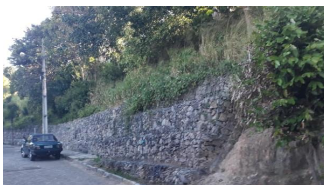
Figura 13 - Muro de contenção acompanha a encosta.
