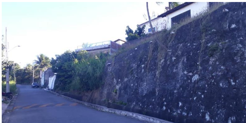
Figura 22 - Muro de contenção.
