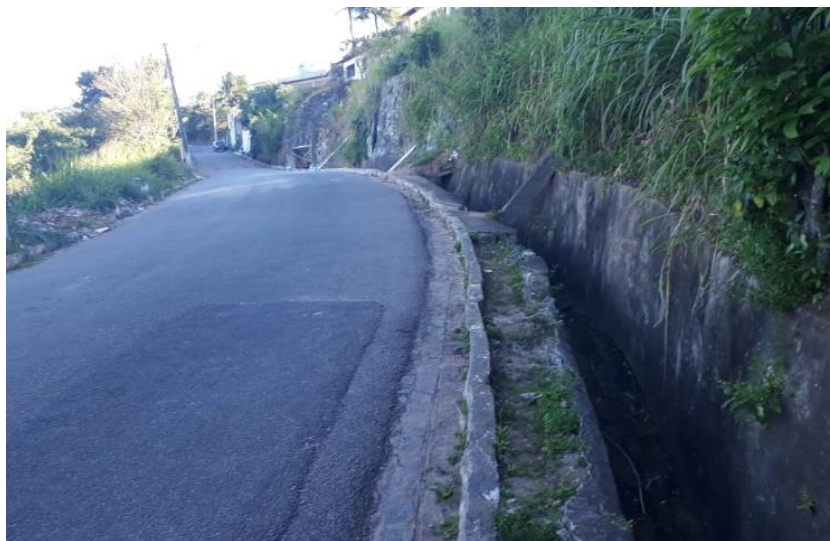
Figura 19 - Sistema de microdrenagem de água pluvial.
