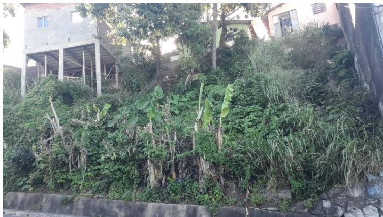
Figura 27 - Casa com as estruturas de sustentação cortando o talude: vista de frente ao talude.
