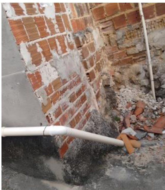
Figura 42 - Tubulação clandestina de águas cinza.
