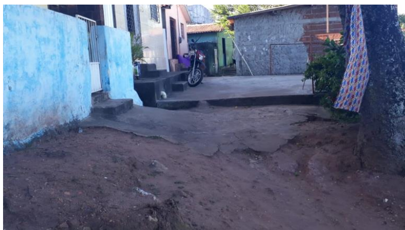
Figura 26 - Evidência de movimento de massa (deslizamento de terra).
