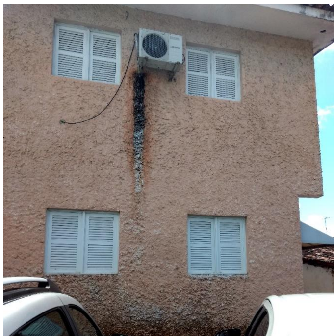
Figura 6 - Aparelho no primeiro andar da instituição e dreno inacessível
