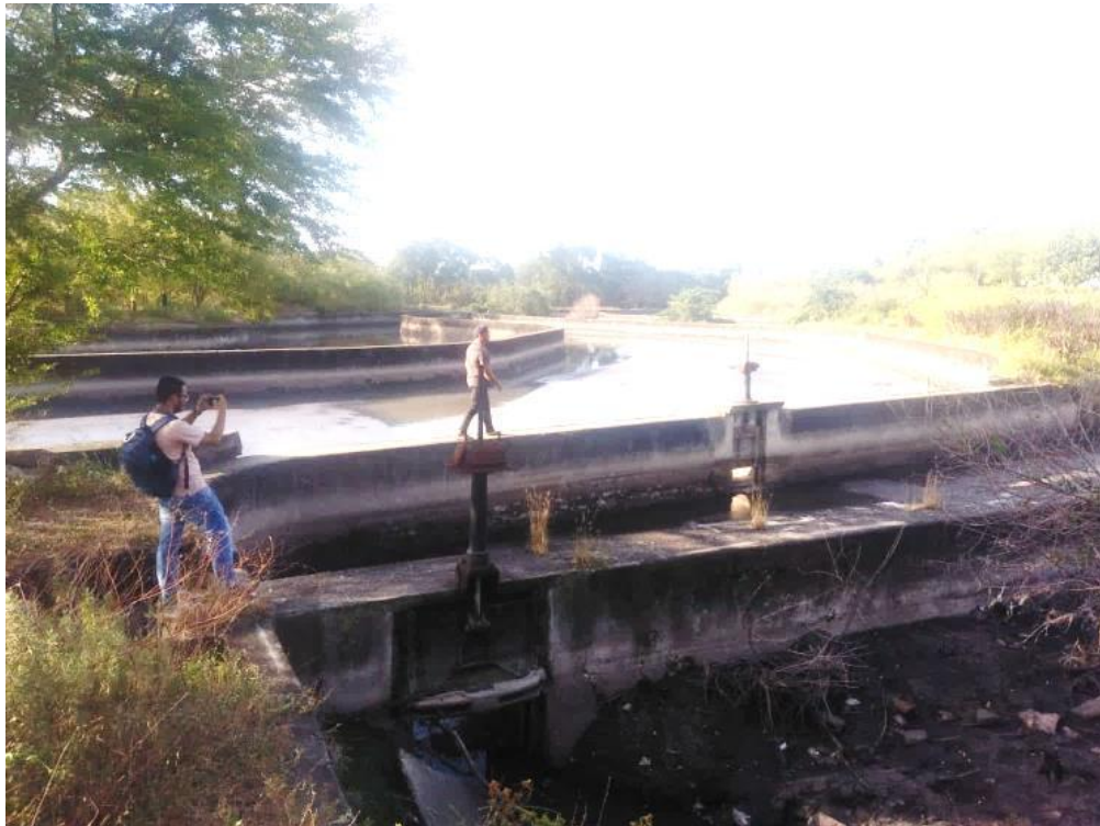
Figura 4: Registro fotográfico da visita a ETEBP
