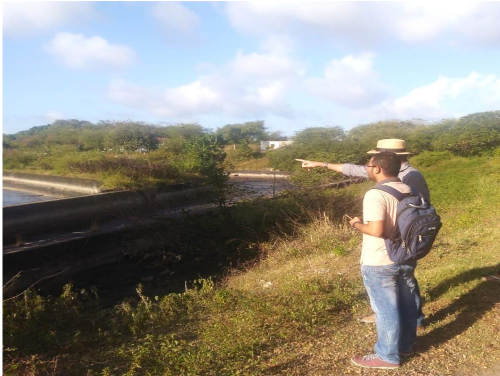
Figura 5: Acompanhamento da visita a ETEBP
