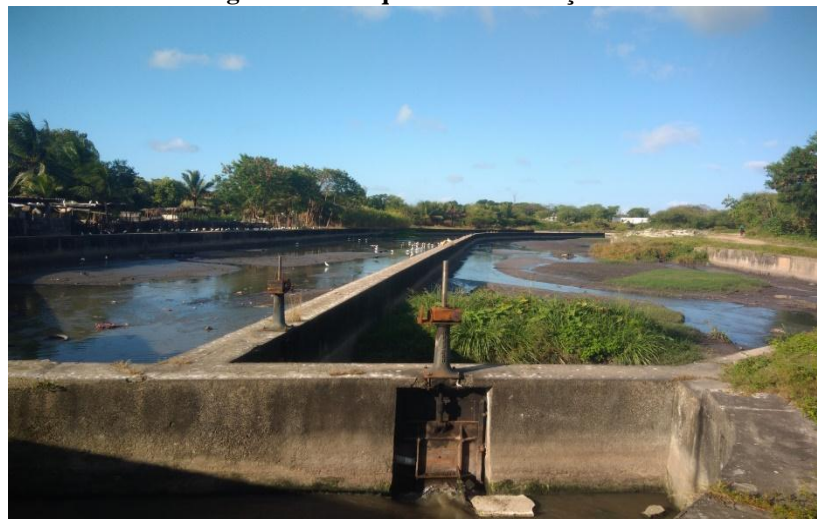
Figura 11: Tanques de acumulação
