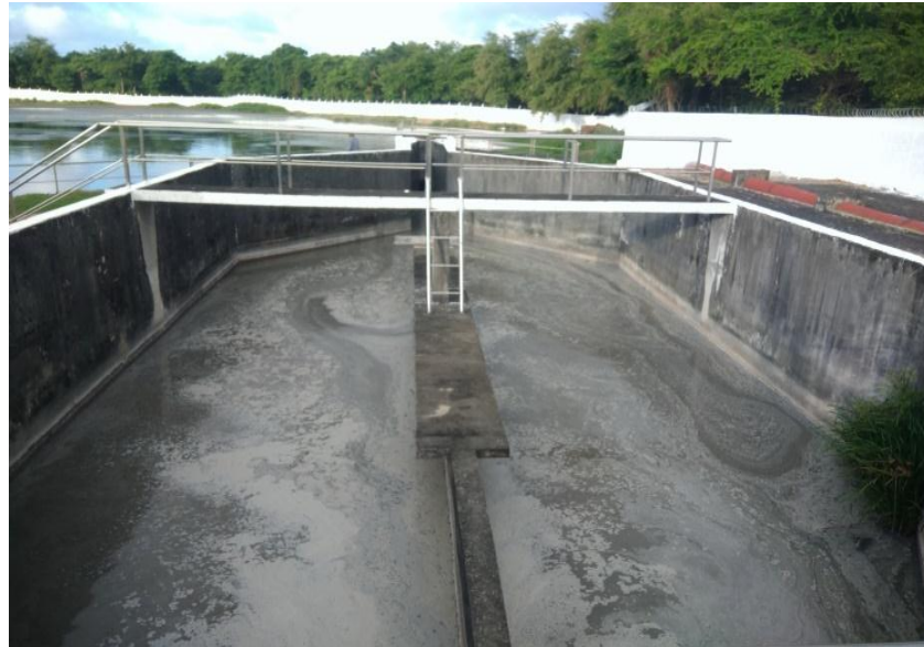
Figura 20: Caixa de areia do tratamento preliminar na ETEBP
