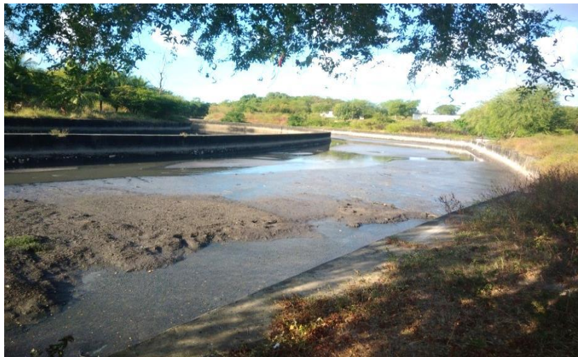
Figura 15: Esgoto sendo acumulação nos tanques na maré baixa
