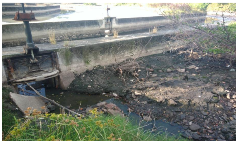
Figura 17: Comporta no tanque de acumulação
