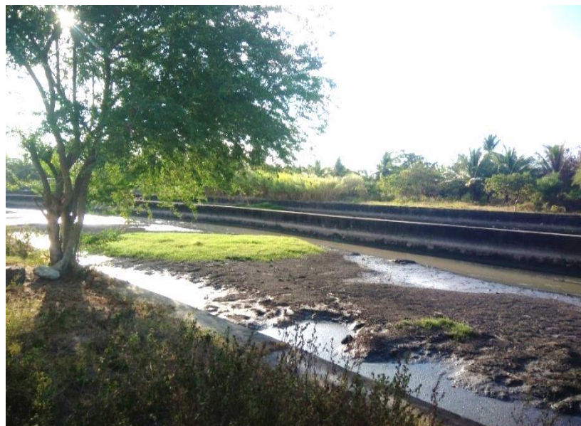
Figura 16: Depósito de lodo ao longo do tanque de acumulação
