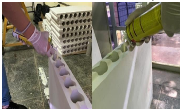
Figura 12: Preenchimento dos vazios com espuma expansiva.
