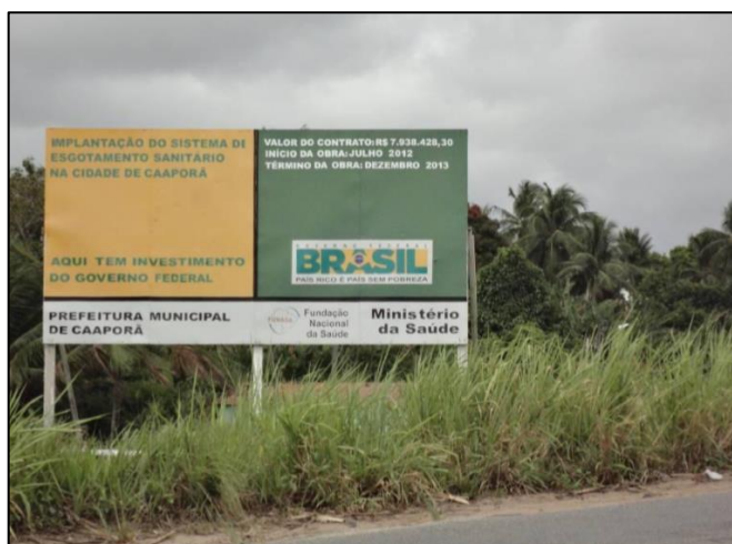
Figura 16 - Placa de identificação da implantação do sistema de esgotamento sanitário na cidade de Caaporã
