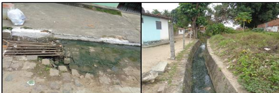
Figura 17 - Esgoto bruto a céu aberto próximo as residências em Caaporã
