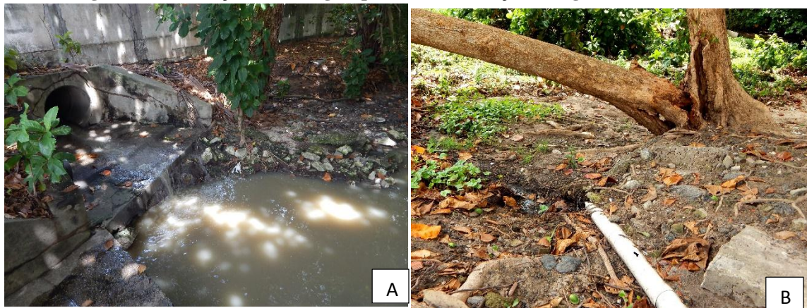
Figura 15: Tubulação de drenagem pluvial e canalização de esgoto na área da nascente
