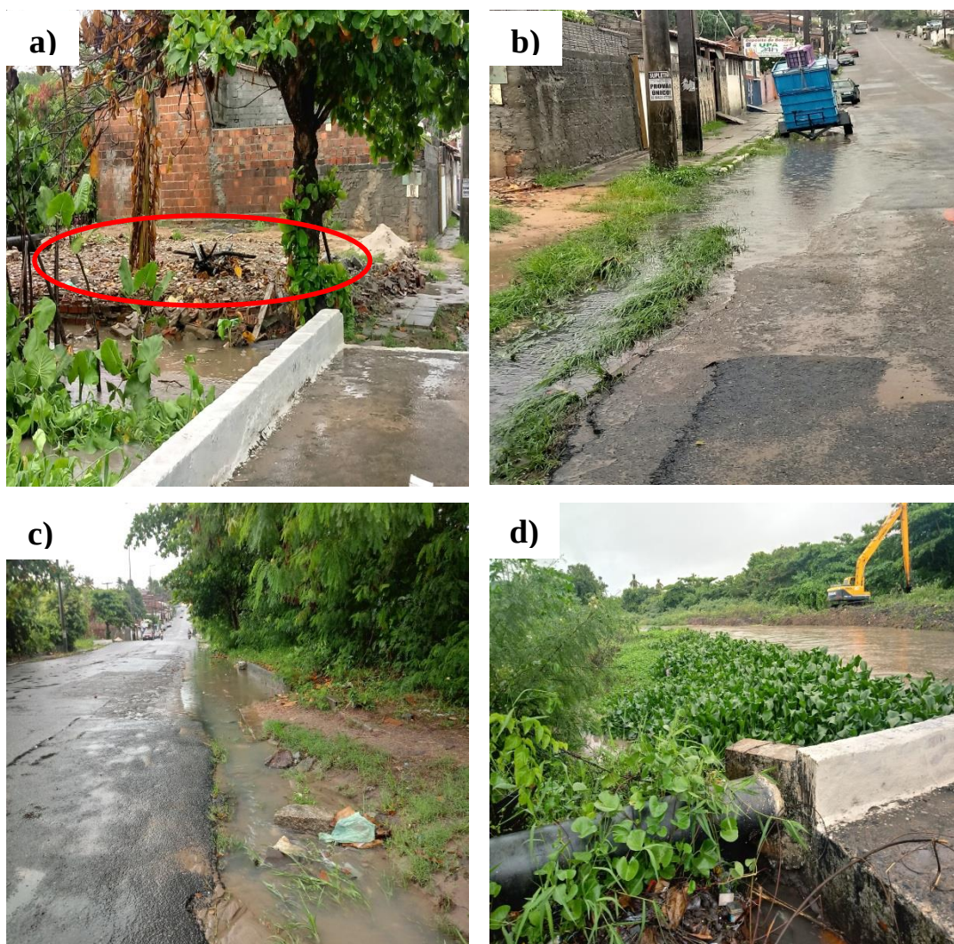
Figura 8: Registro da área de estudo no dia 13 de fevereiro de 2019 sobre a ponte do rio Cuiá, ligando a rua Francisco Porfírio Ribeiro, no Bairro de Mangabeira à rua Brasilino Alves da Nóbrega, no Bairro do Valentina: a) e b) representam as margens à montante da ponte e c) e d) representam as margens à jusante da ponte. Fonte: autora.
