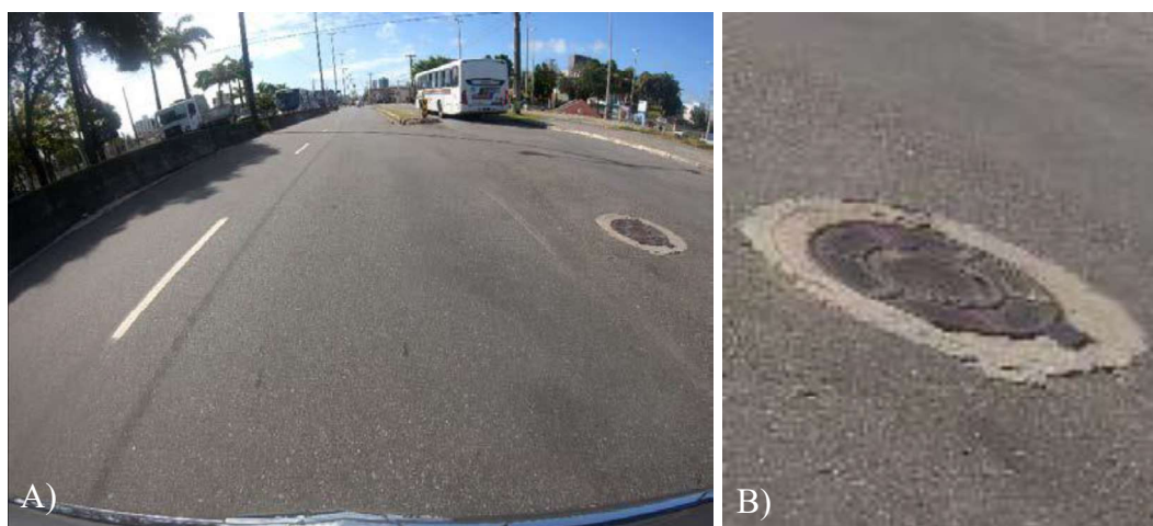
Figura 10 — Exemplo de dificuldade de identificação de poço de visita no trecho 1: A) Visão geral da câmera e B) Zoom do poço de visita localizado
