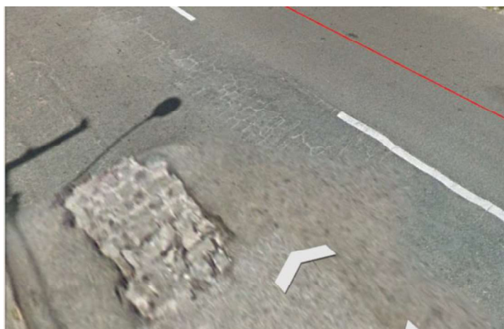
Figura 15 - Exemplo de Aparecimento de Paralelos (Trecho 51)
