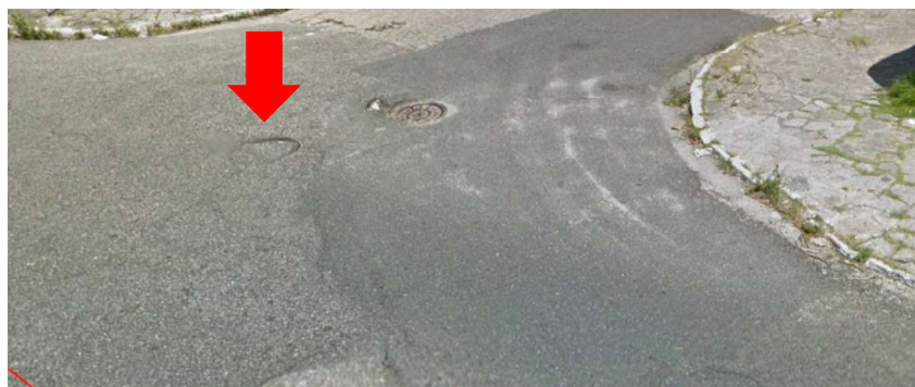
Figura 17 - Camada de Pavimento Executada Acima da Tampa do Poço de visita (Trecho 40)
