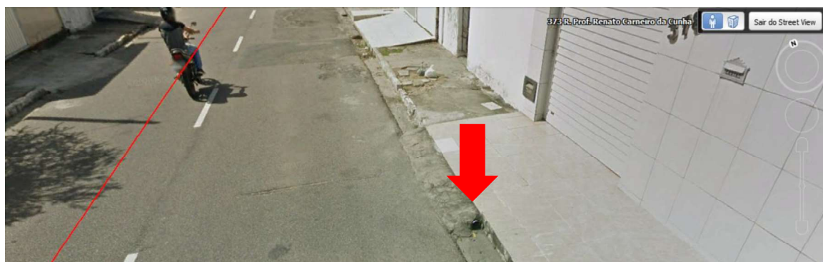
Figura 21 - Exemplo de Inclinação Alterada, mas Sem Impedimento ao Fluxo (Trecho 56)
