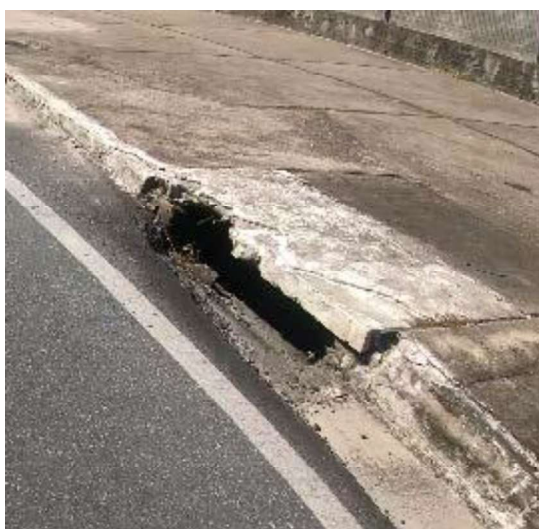
Figura 16 - Exemplo do registro da condição de boca de lobo localizada no trecho 02
