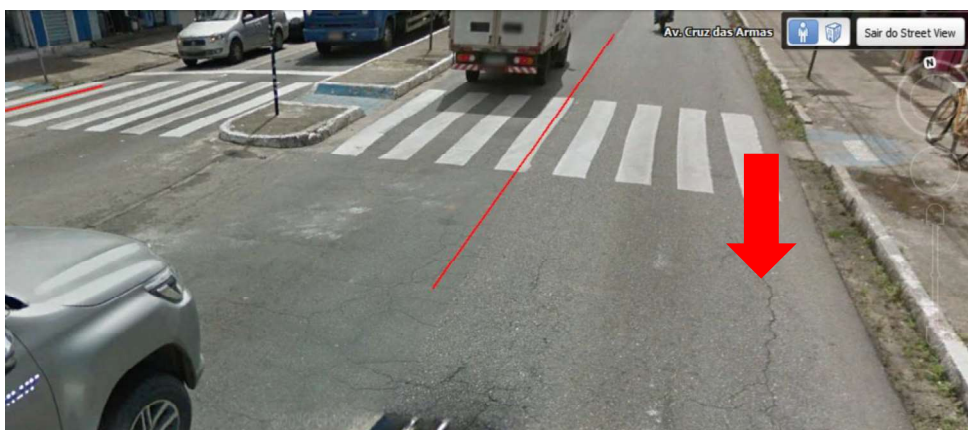
Figura 14 - Exemplo de Trinca de Fácil Identificação (Trecho 61)
