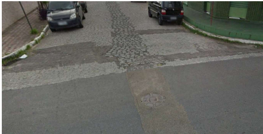
Figura 18 - Abertura do Pavimento para Instalação/Manutenção do Sistema Sanitário (Trecho 57)
