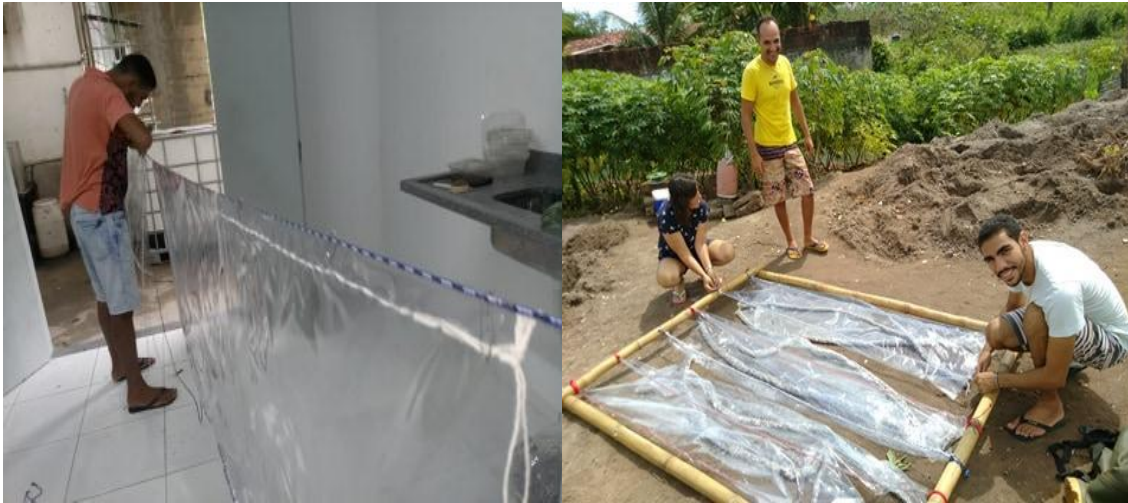
Figura 2: Construção das “cortinas” de biofilme e das estruturas de sustentação.
