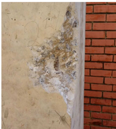
Figura 25 - Armadura exposta para ligação no voltímetro (Pilar 1).
