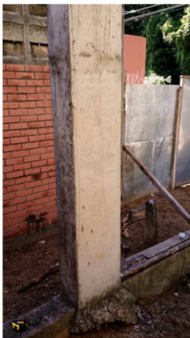
Figura 29 - Pilar estudado da estrutura lateral ao RU (Pilar 1).
