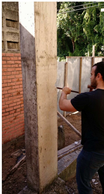
Figura 24 - Abertura no cobrimento do concreto para ligação da armadura com o voltímetro (Pilar 1).
