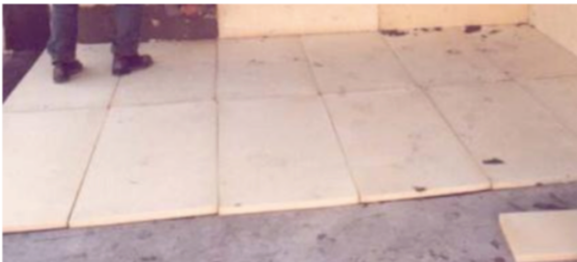
Figura 6 - Placas de poliestireno expandido e modificado
