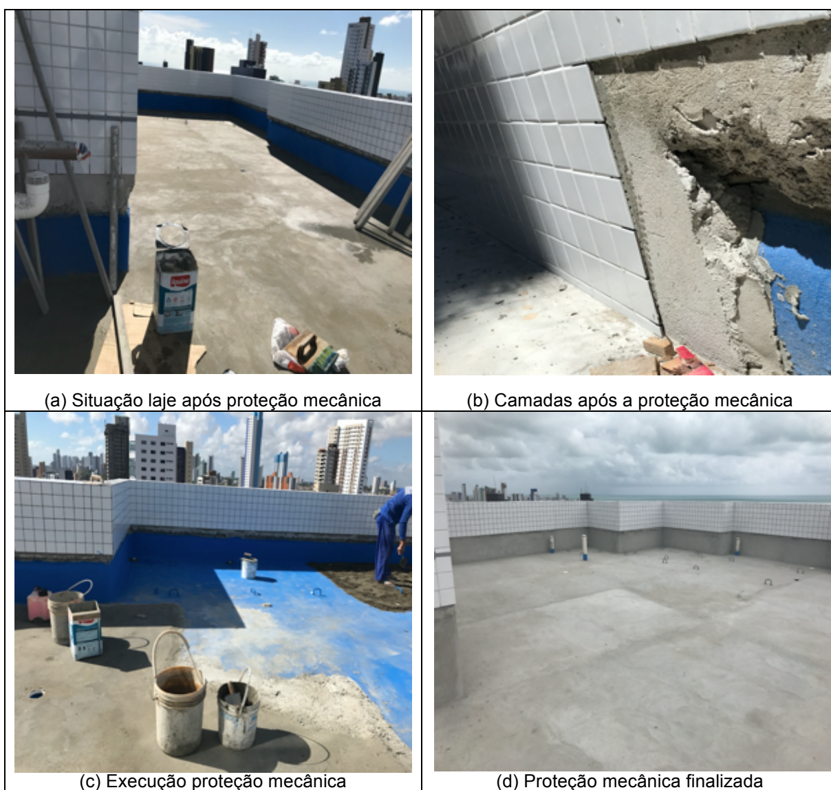
Figura 18 Execução de proteção mecânica
