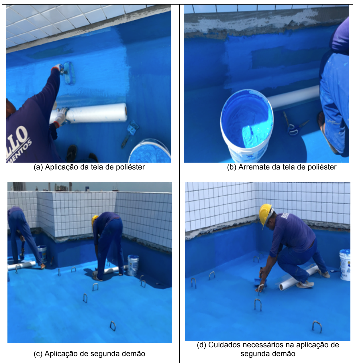
Figura 16 Execução de segunda demão de membrana acrílica
