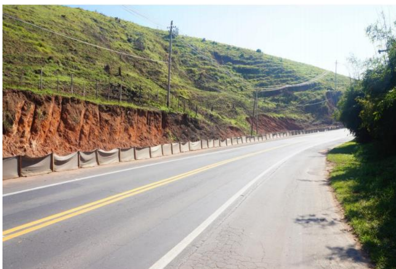
Figura 18: Vista geral após a instalação da barreira.
