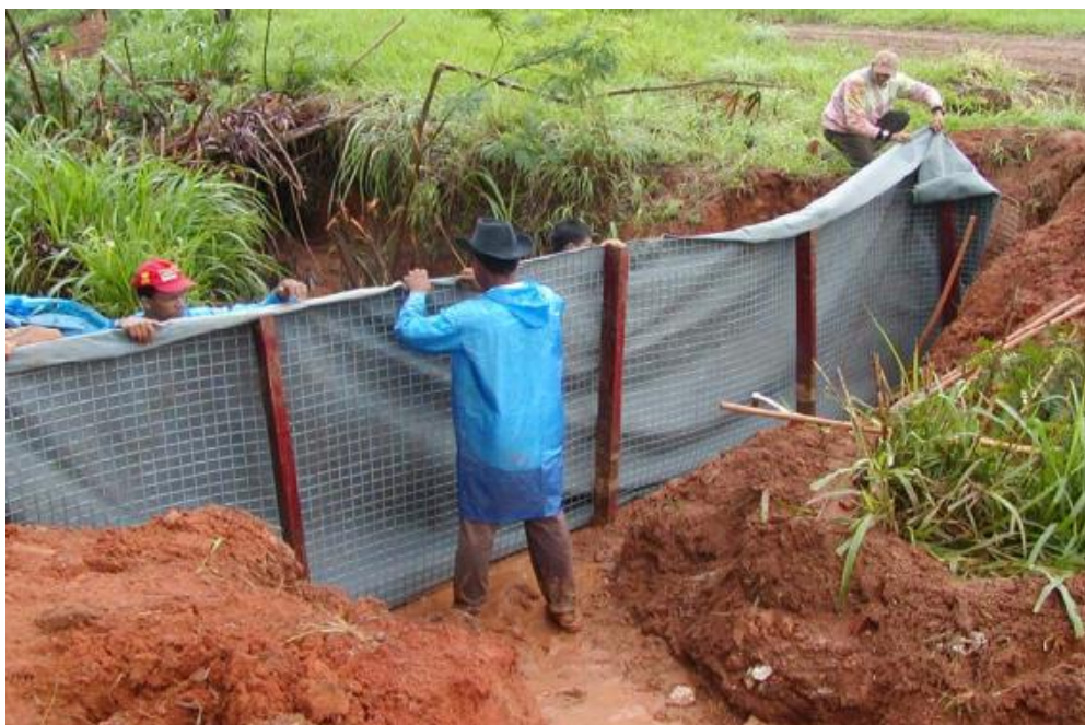
Figura 12: Instalação do geotêxtil
