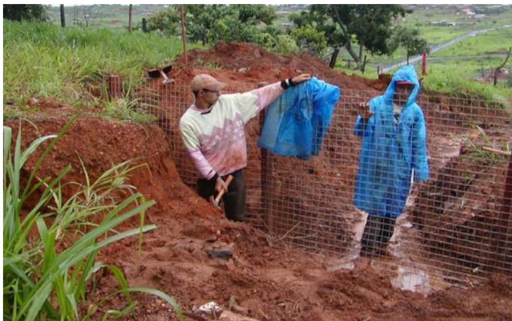
Figura 11: Instalação das hastes de madeira e da tela metálica.
