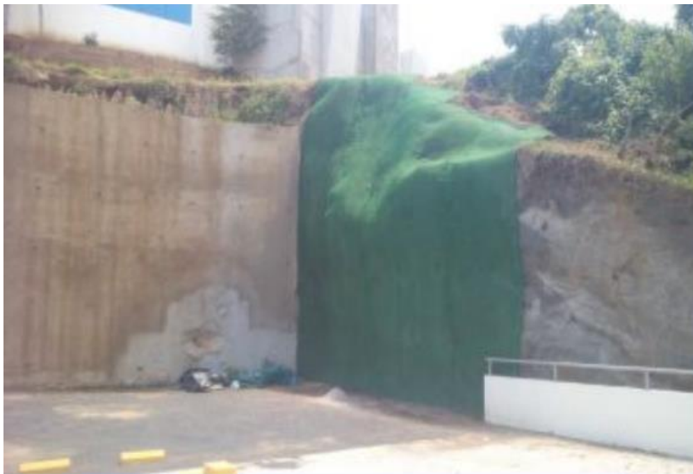
Figura 23: Registro da situação da encosta com a obra concluída.
