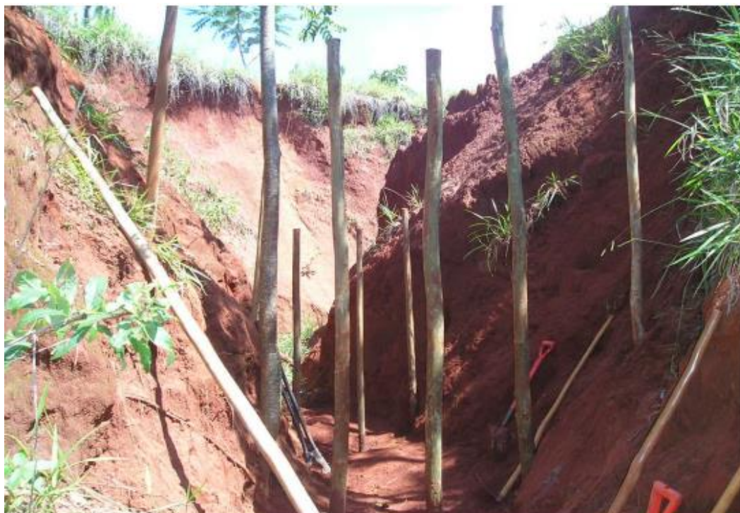
Figura 15: Hastes de madeira instaladas.
