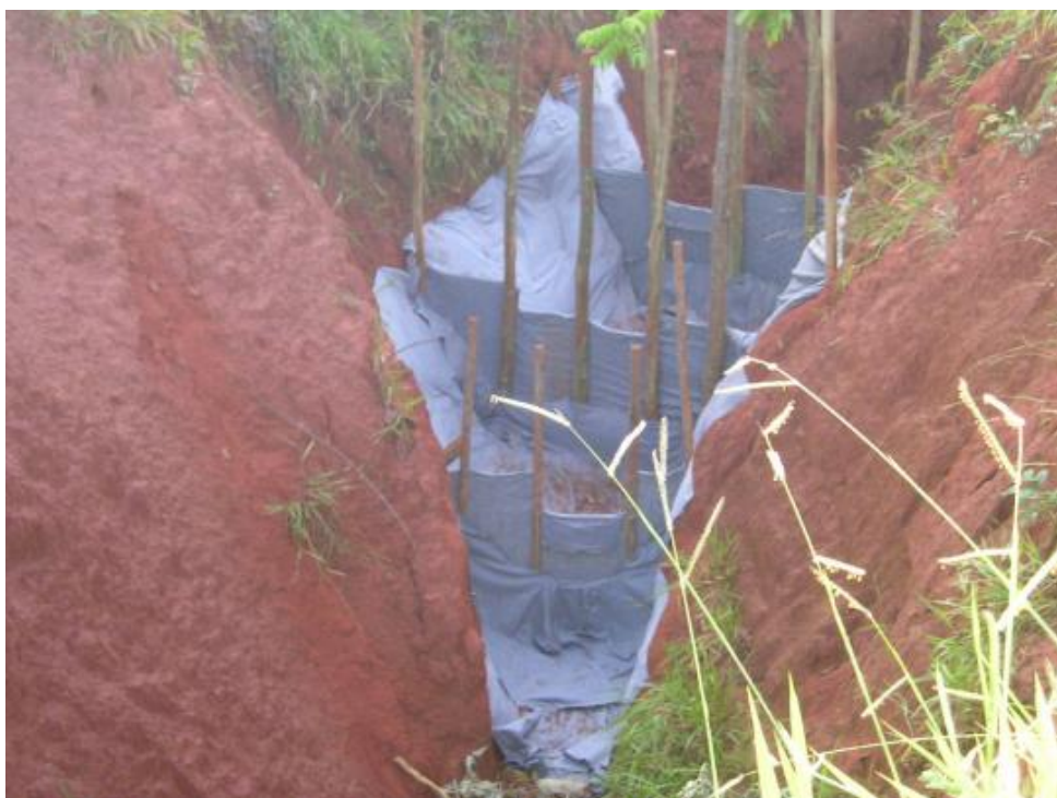
Figura 17: Vista geral da obra executada.
