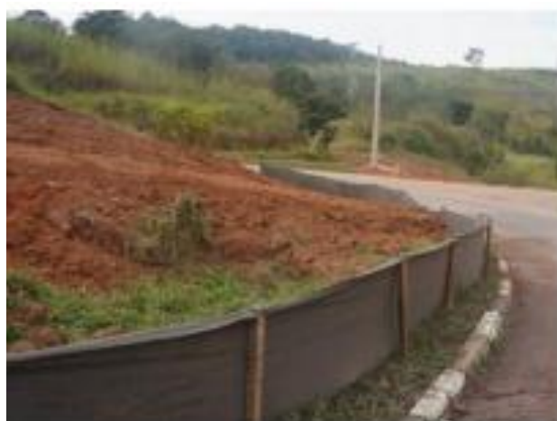
Figura 19: Barreira de sedimento realizada com geotêxtil.
