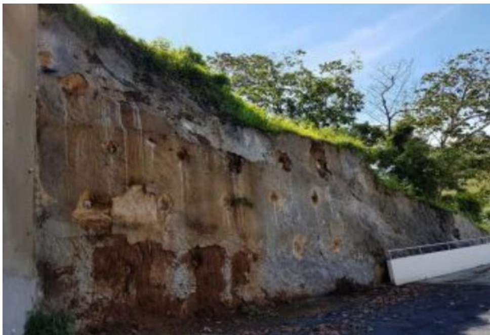
Figura 22: Registro da situação da encosta antes da obra.
