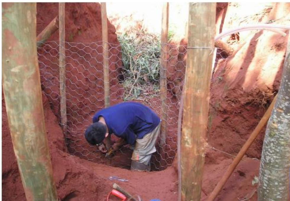
Figura 16: Instalação das telas metálicas
