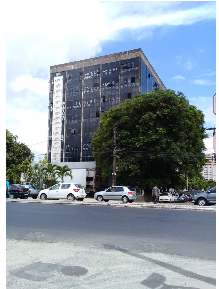
Imagem 1 - Foto do edifício em seu estado atual. Fonte: Tirada em 23 nov. 2020, acervo da autora.
