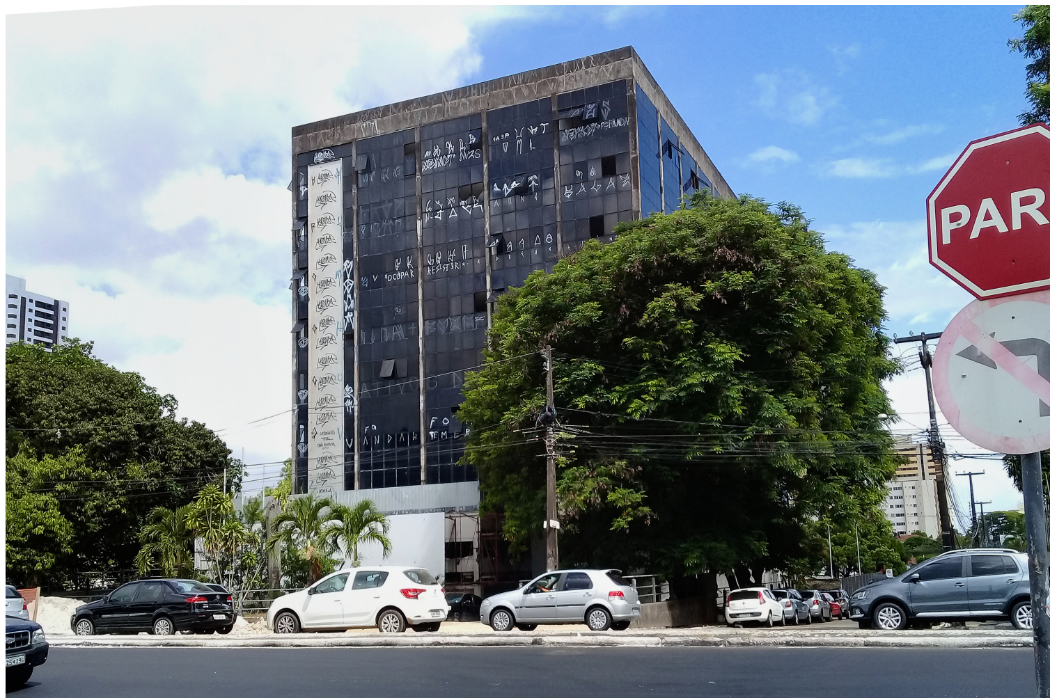
Imagem 14 - Foto do edifício em seu estado atual. Fonte: Tirada em 23 nov. 2020, acervo da autora.
