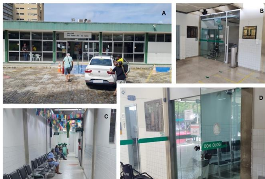
Figura 2 - Imagens da fachada do setor ambulatorial do HULW e seu hall de entrada, porta principal e sala de espera da USB
