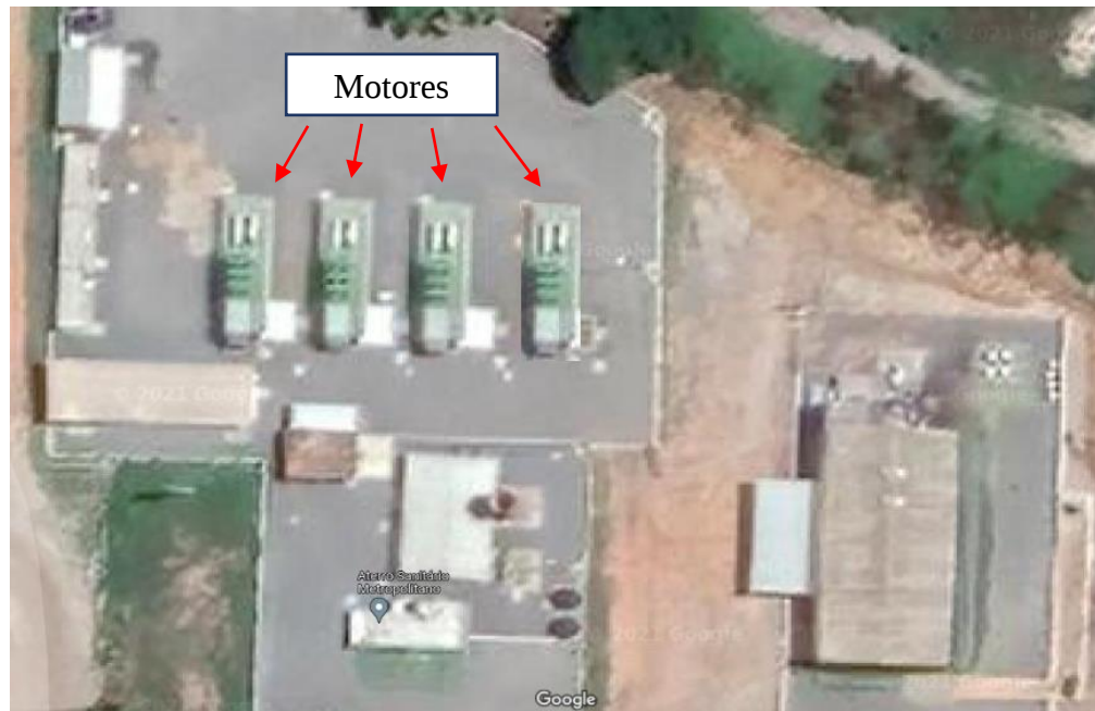
Figura 2.10. Vista aérea da usina de biogás no ASMJP.
