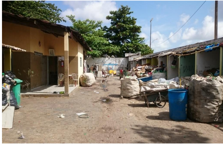
Figura 6 - Instalações internas do núcleo do Bairro dos Estados.
