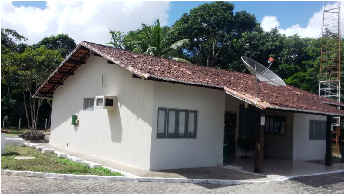
Figura 18 Infraestrutura da REBIO Guaribas. (Foto: Igor Quaresma, Maio de 2017).
