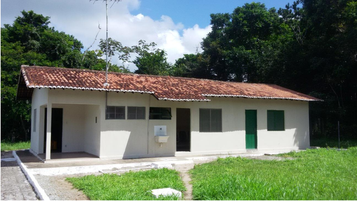
Figura 17 Infraestrutura da REBIO Guaribas. (Foto: Igor Quaresma, Maio de 2017).
