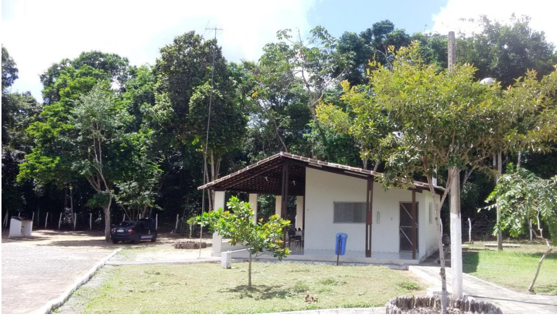
Figura 19 Infraestrutura da REBIO Guaribas (Foto: Igor Quaresma, Maio de 2017).
