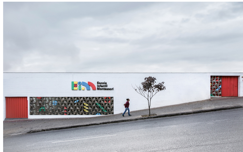
Figura 20: Escola Infantil Montessori Belo Horizonte (fachada principal)
