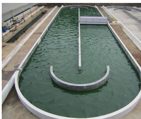
Figura 4 - Tanque de cultivo de microalgas do tipo raceway.
