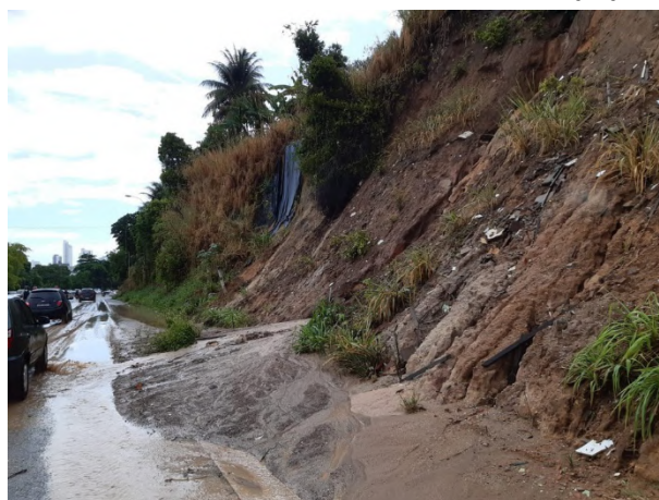
Figura 48 - Deslizamento ocorrido em fevereiro de 2020 na BR-230/PB
