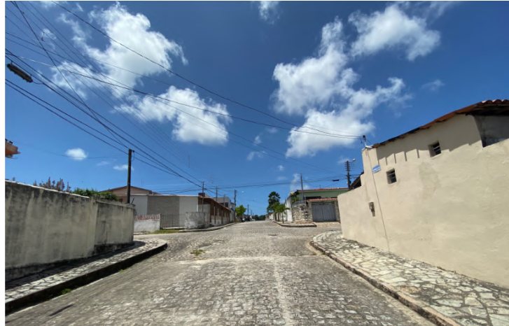
Figura 60 - Ruas calçadas nas proximidades do talude
