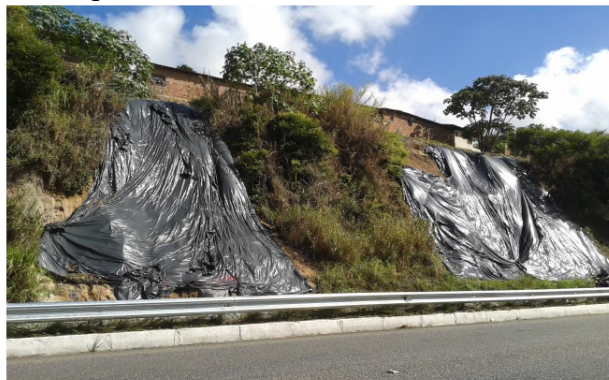
Figura 50 - Lonas plásticas instaladas na face do talude no ano de 2014
