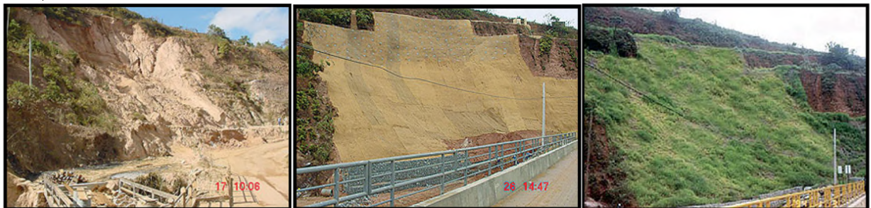
Figura 14 - Antes, durante e depois da execução de solo grampeado verde e biomantas antierosivas em talude com instabilidade geral, escorregamento e erosões generalizadas
