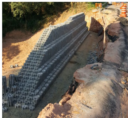
Figura 23 - Muro de contenção em LogBlock Contenção
