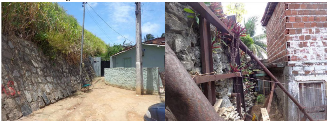
Figura 63 - Muros de arrimo da Comunidade São Rafael
