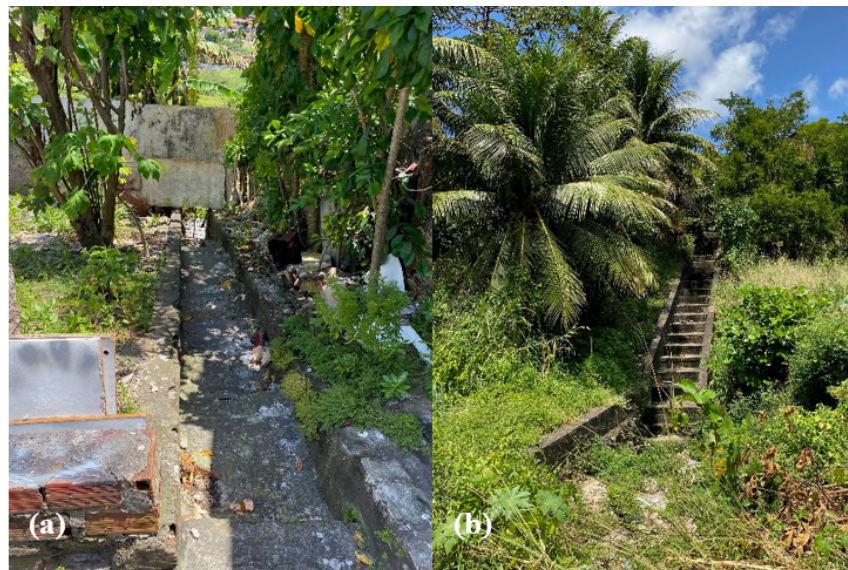
Figura 62 - Dispositivos para drenagem das águas pluviais do tipo escadaria hidráulica
