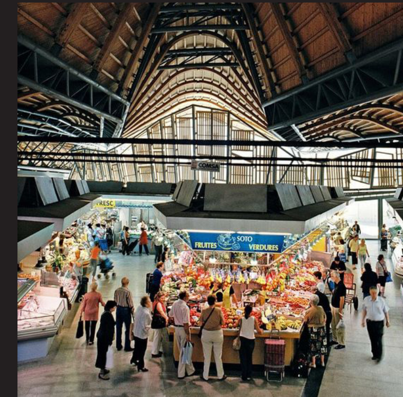
REABILITAÇÃO DO MERCADO SANTA CATERINA. BARCELONA, ESPANHA. PROJETO: EMBT ARQUITETOS ASSOCIADOS
