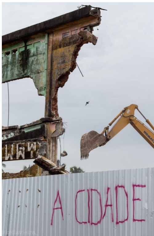
Figura 43 - Demolição da última parede dos galpões do Cais José Estelita
