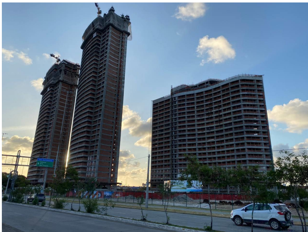
Figura 44 - Empreendimento “Mirante do Cais” sendo construído no espaço onde ficavam os galpões do Cais José Estelita
