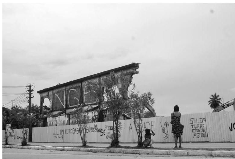
Figura 42 - Última parede demolida dos galpões do Cais José Estelita
