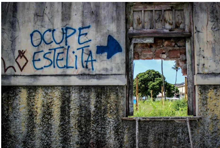
Figura 14 - Buraco aberto na parede do Cais pelos primeiros manifestantes que começaram a ocupar o terreno para impedir a sua demolição
