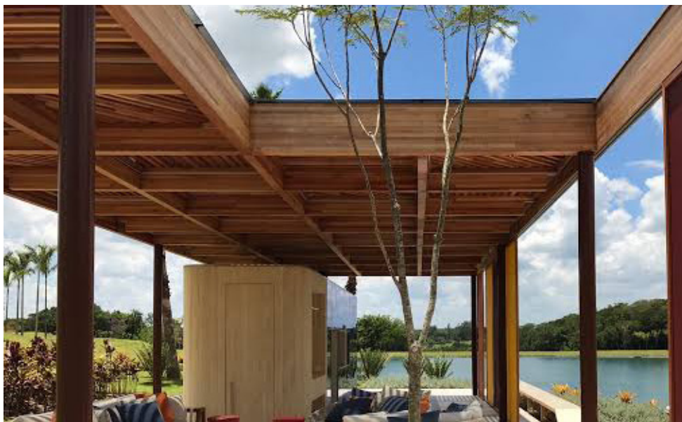
Imagem 55: Estrutura em Madeira Laminada Colada (MLC) Fonte: https://rewood.com.br/
