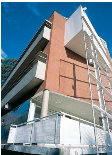
O armário em balanço, no segundo andar, destaca-se na quina do volume junto ao córrego.
