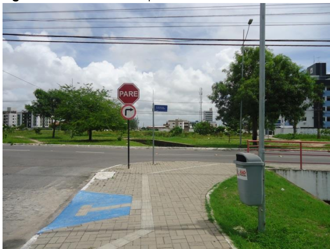
Figura 75: Piso tátil e rampa de acesso na borda do ELP
