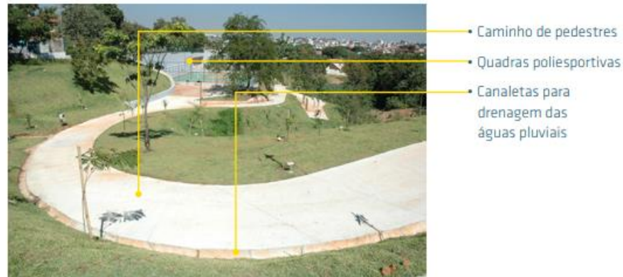
Figura 10: Elementos de Parques Lineares – Parque Linear Córrego 1º de Maio, Belo Horizonte, MG
