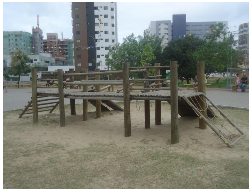
Figura 76: Objeto de arvorismo, implantado sob areia e gramado raso, impedindo o acesso a PD
