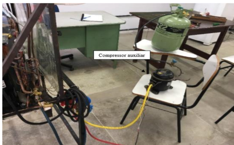
Figura 15 - Retirada de fluido refrigerante do sistema.
