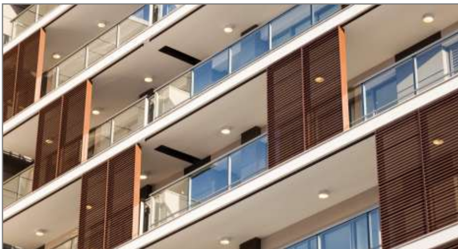
Figura 27 - Detalhe do painéis móveis na torre residencial Edifício MEET
