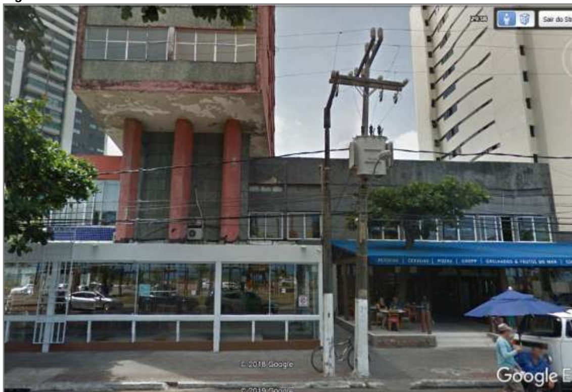
Figura 12 - Fachada leste Ed. Califórnia
