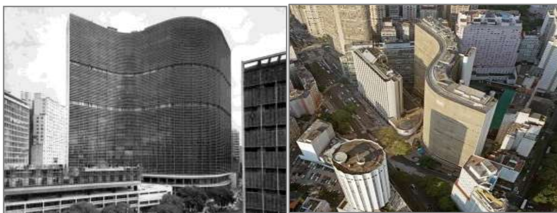
Figura 6 - Fachada principal Ed. COPAN Figura 7 - Vista aérea Ed. COPAN
