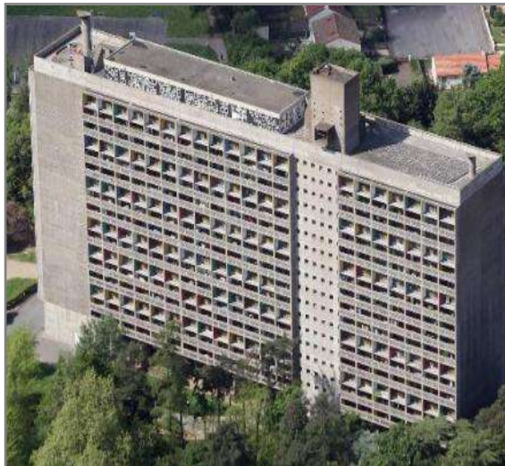
Figura 1- Unidade Habitação Nantes
