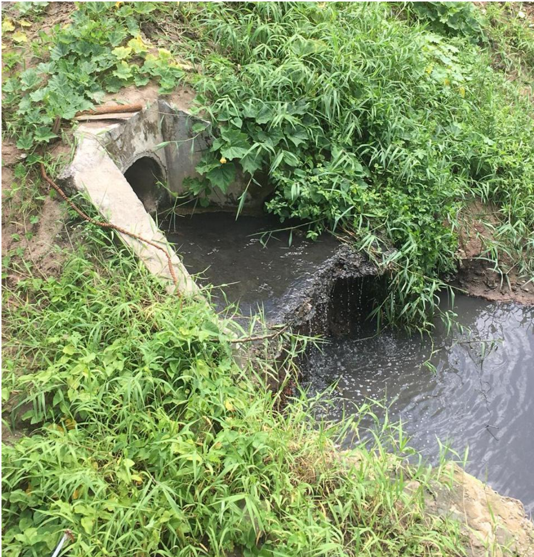
Figura 11 - Lançamento de efluente no trecho do rio do ponto JB03.
