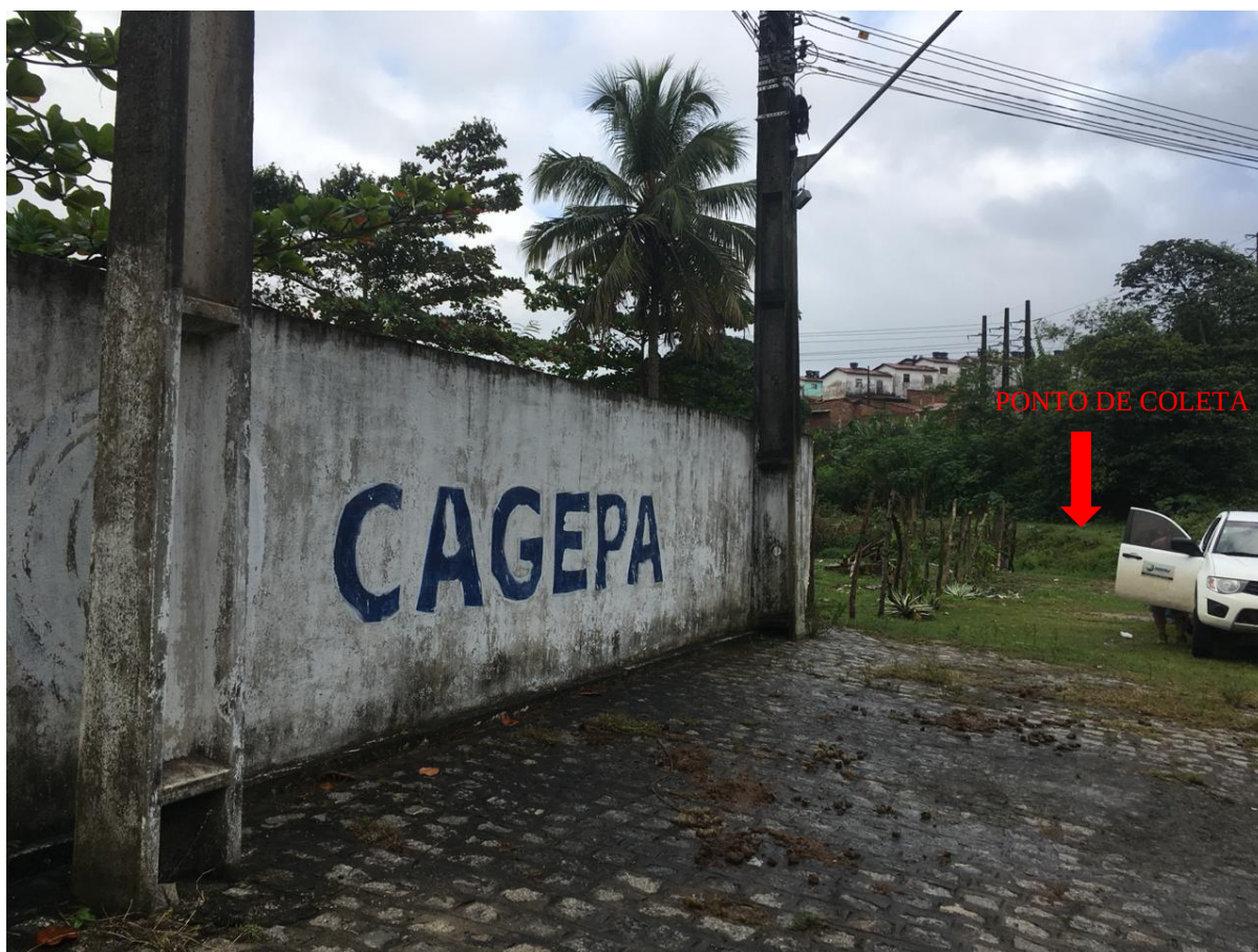
Figura 7 - Estação elevatória da CAGEPA próximo ao ponto JB01.
