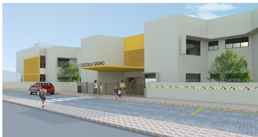
Figura 27 - Vista Oeste do Acesso Principal da Escola Signo
