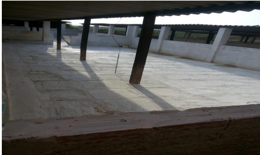
Figura 9. Vazio sanitário em instalação de creche.
