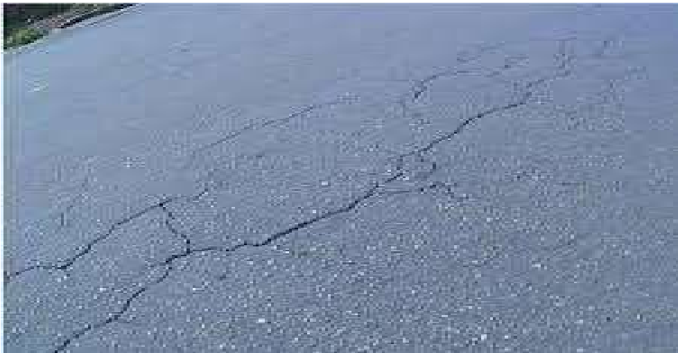
Figura 9: Retração Fonte: DNIT- Departamento Nacional de infraestrutura de transportes (2003 p 57).
