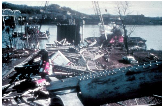
Figura 6 - Colapso da Silver Bridge
