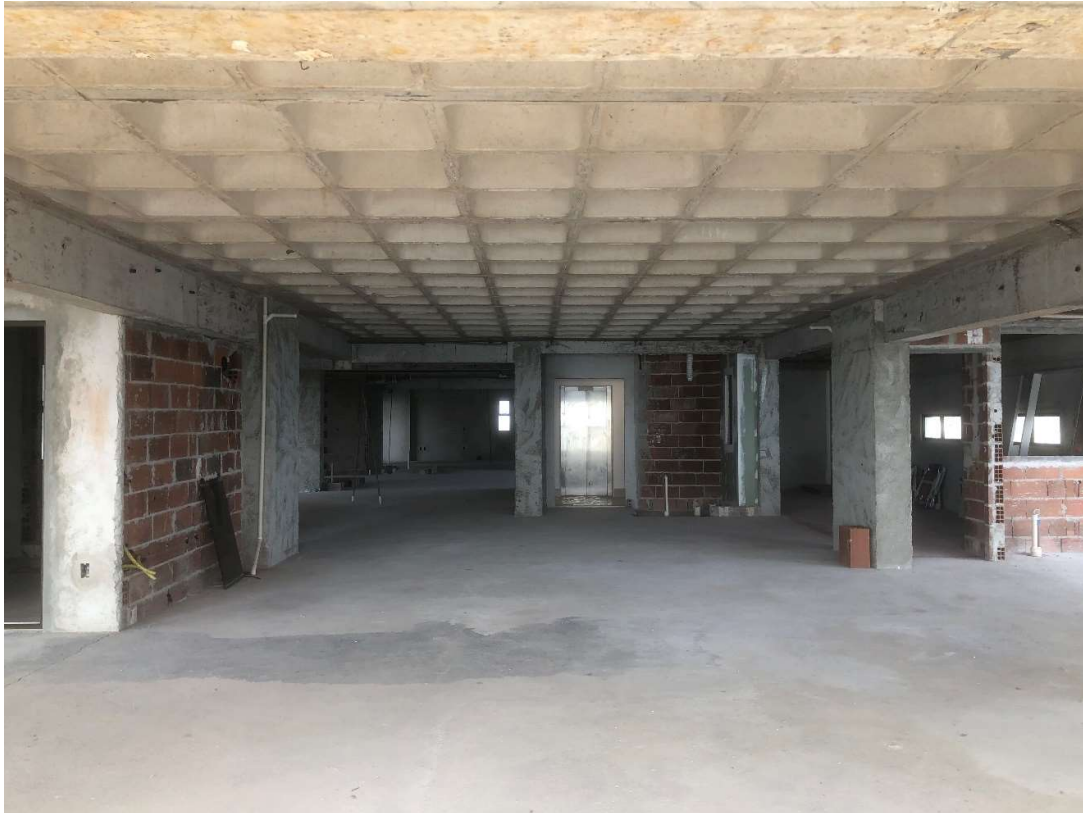
Figura 5 – Pavimento do prédio
