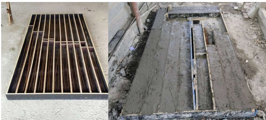
Figura 12 - Forma para confecção de vergas e contravergas sem concreto (à esquerda) e concretada (à direita)
