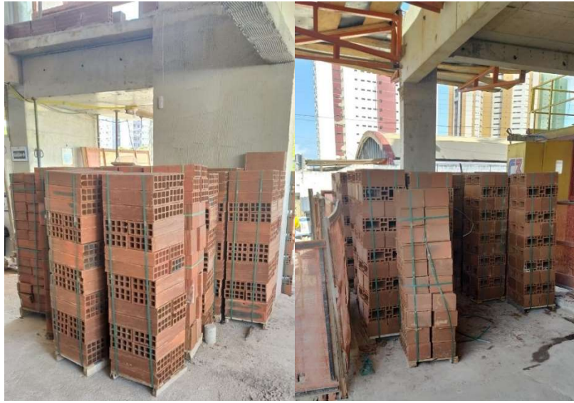
Figura 11 - Blocos e tijolos armazenados no pavimento térreo
