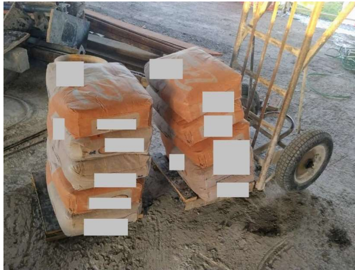
Figura 17 - Sacos de argamassa disponibilizados no pavimento
