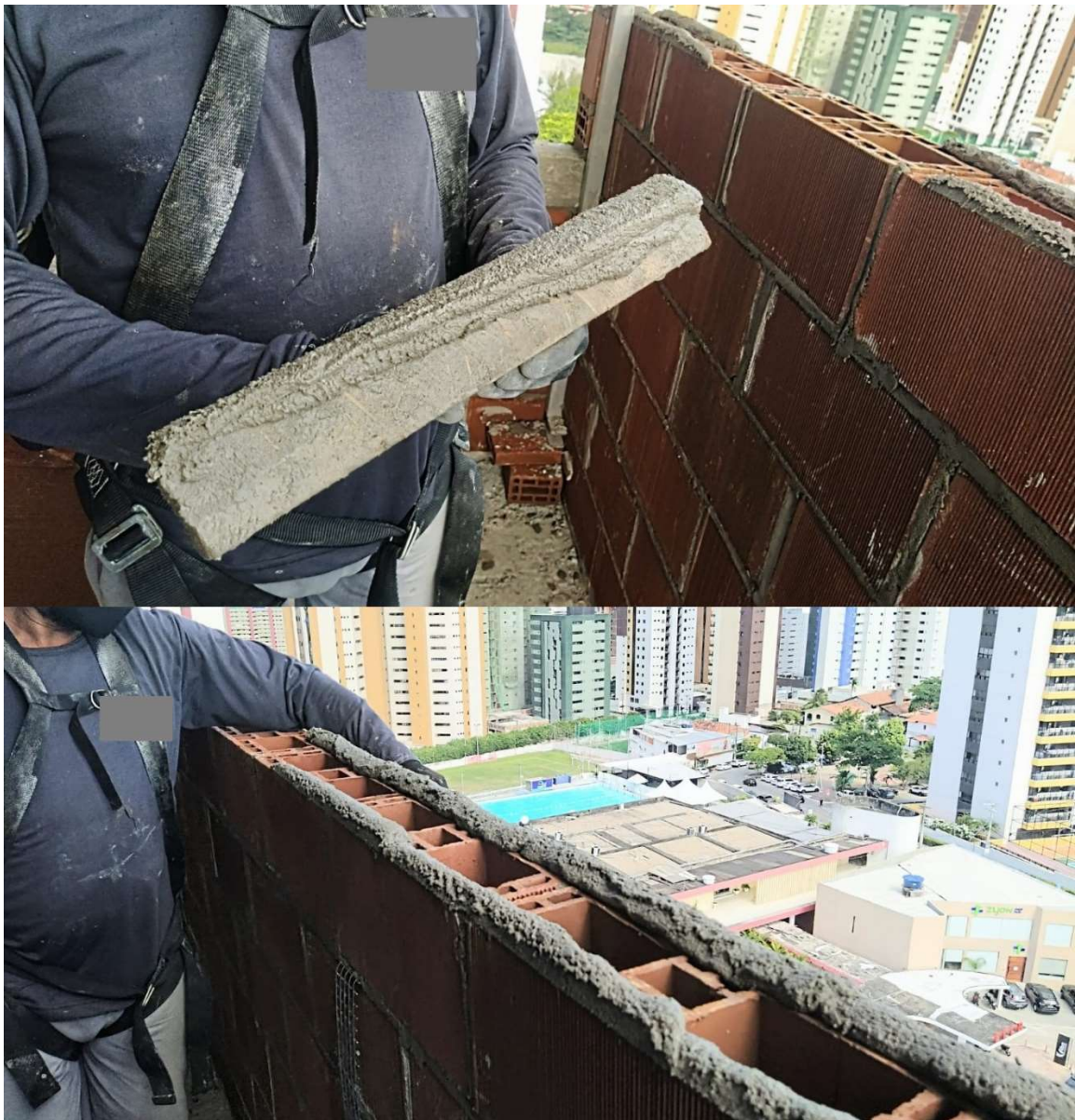
Figura 19 - Utilização da palheta de madeira para aplicação da argamassa de assentamento industrializada
