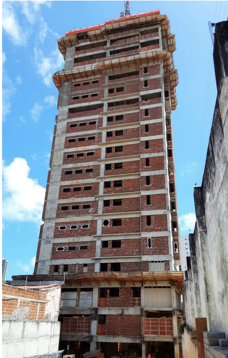
Figura 14 - Alvenaria externa da fachada oeste
