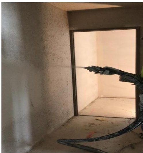
Imagem 17 – Aplicação de massa corrida projetada
