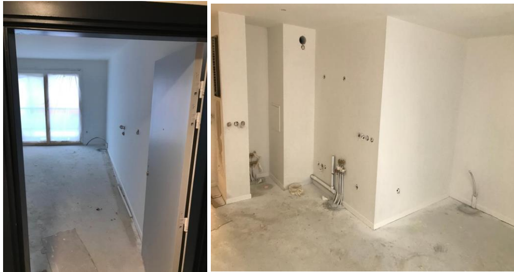
Imagem 18 – Pintura dos apartamentos
