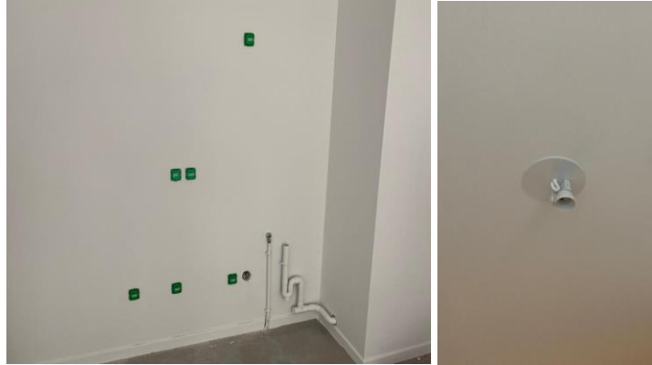
Imagem 14 – Instalação de acabamentos elétricos
