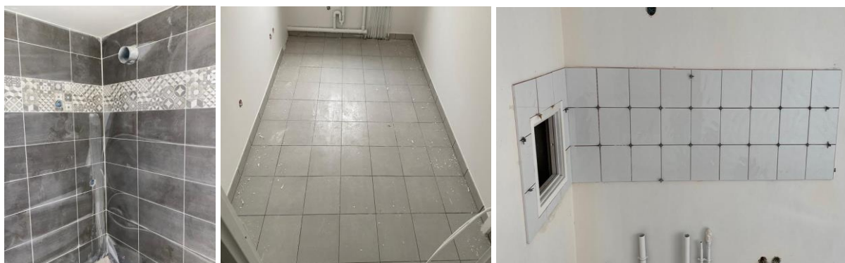
Imagem 20 – Aplicação de revestimento cerâmico
