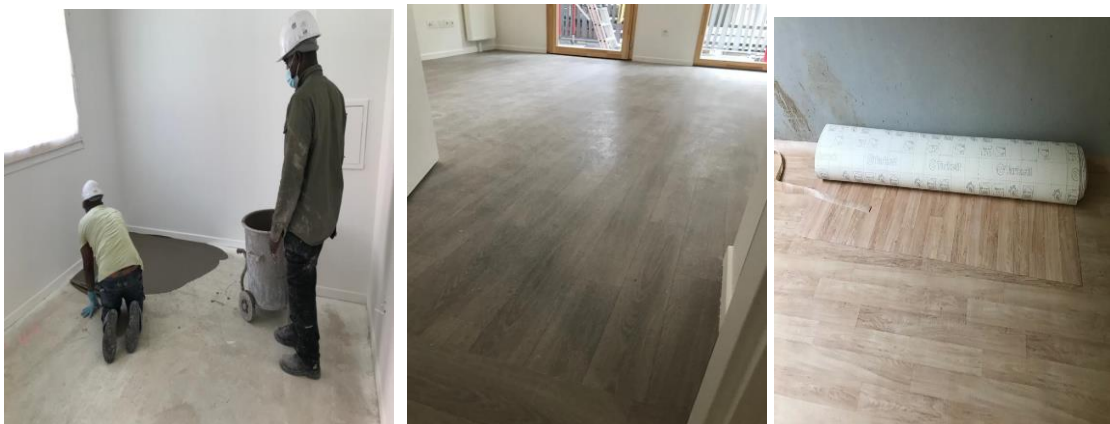
Imagem 19 – Aplicação de autonivelante e piso vinílico
