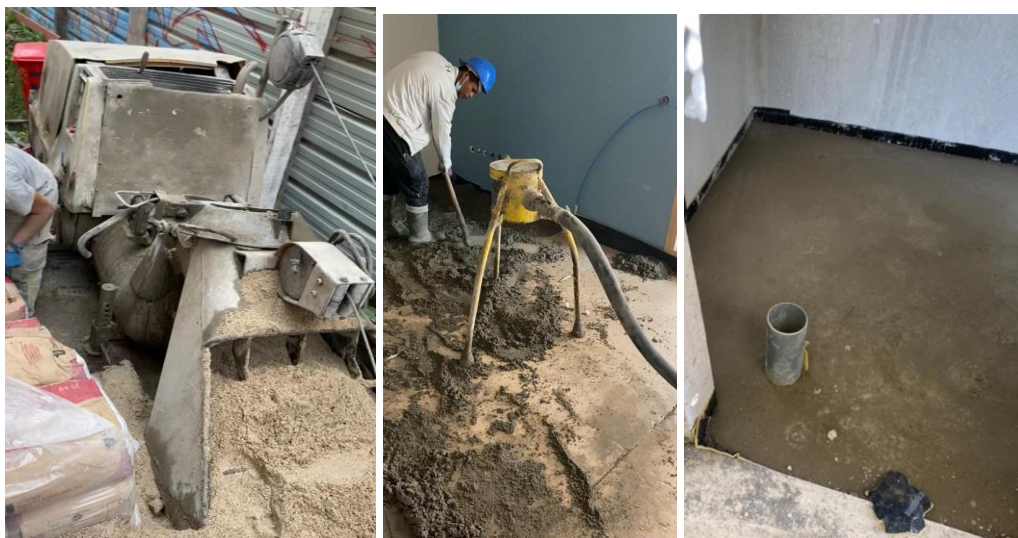
Imagem 25 – Execução de contrapiso com bomba italiana
