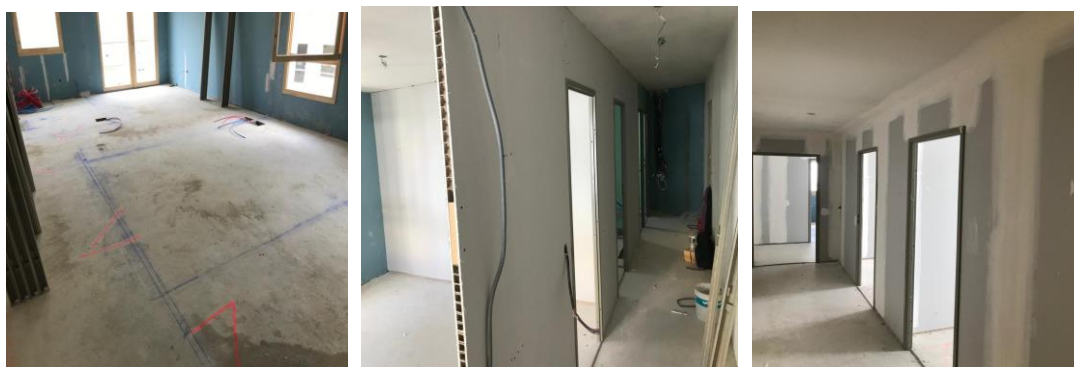
Imagem 16 – Execução de vedação em “Placopan”
