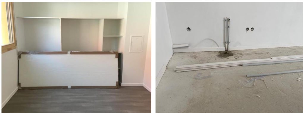
Imagem 21 – Instalação de marcenaria: móveis e rodapés
