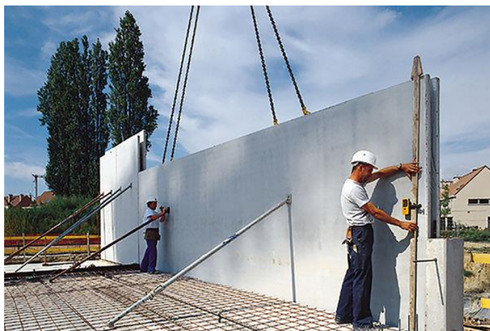
Imagem 6 – Execução de muro pré-fabricado
