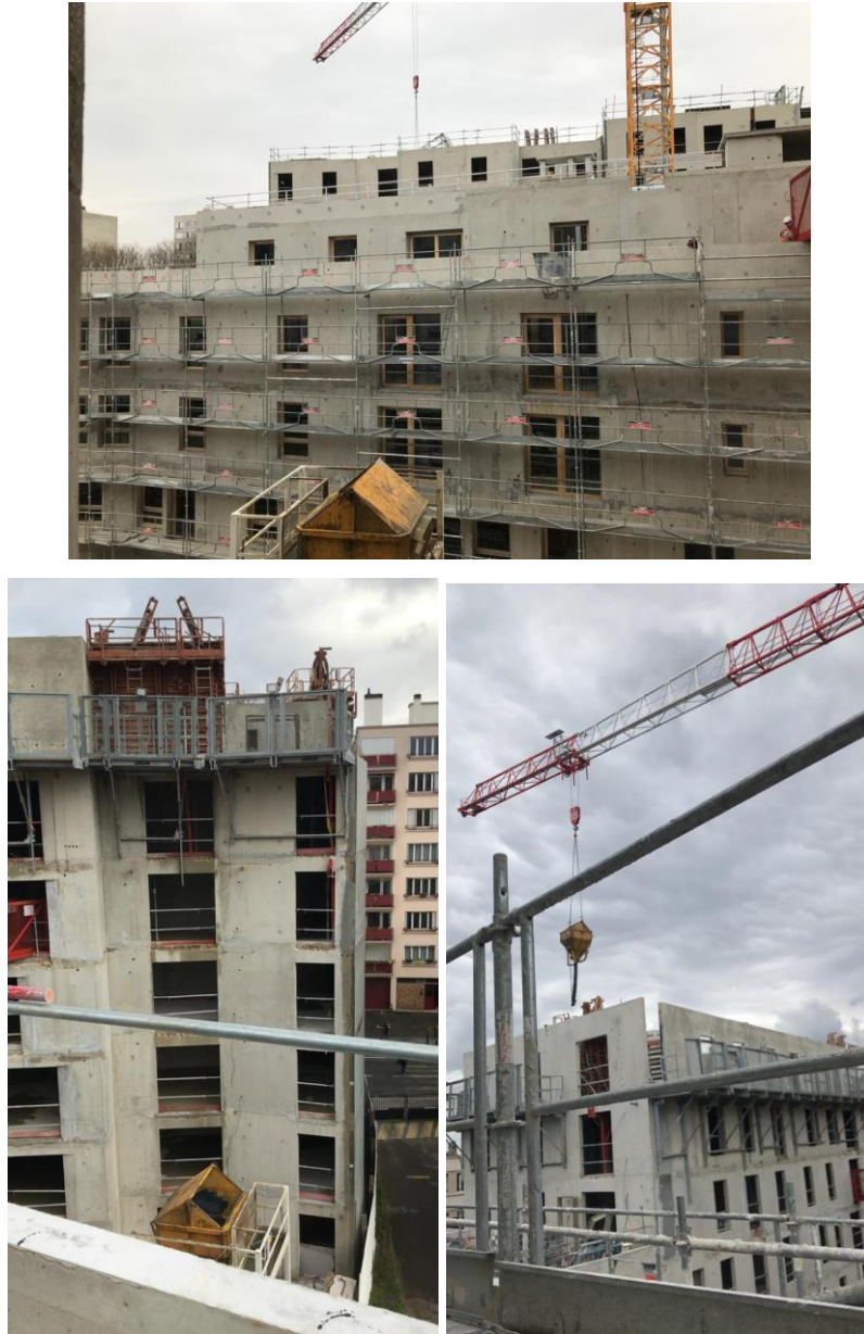
Imagem 5 – Execução de parede de concreto in loco
